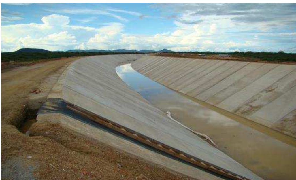
Figura 3: Trecho da obra da Transposição do Rio São Francisco.
