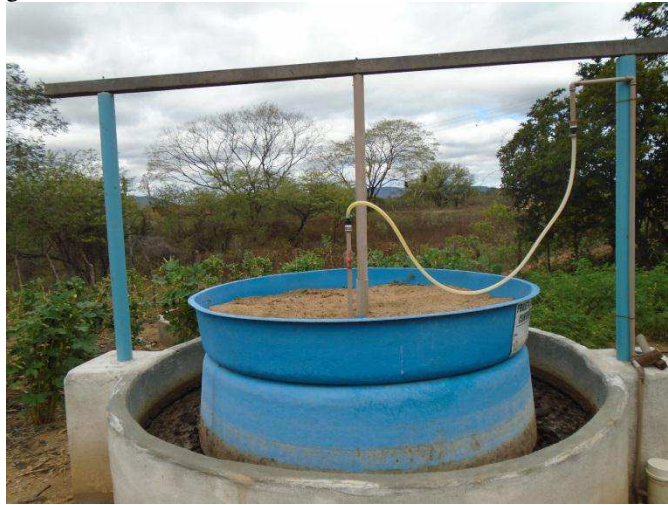
Foto 5: biodigestor, tecnologia social utilizado na produção de gás
