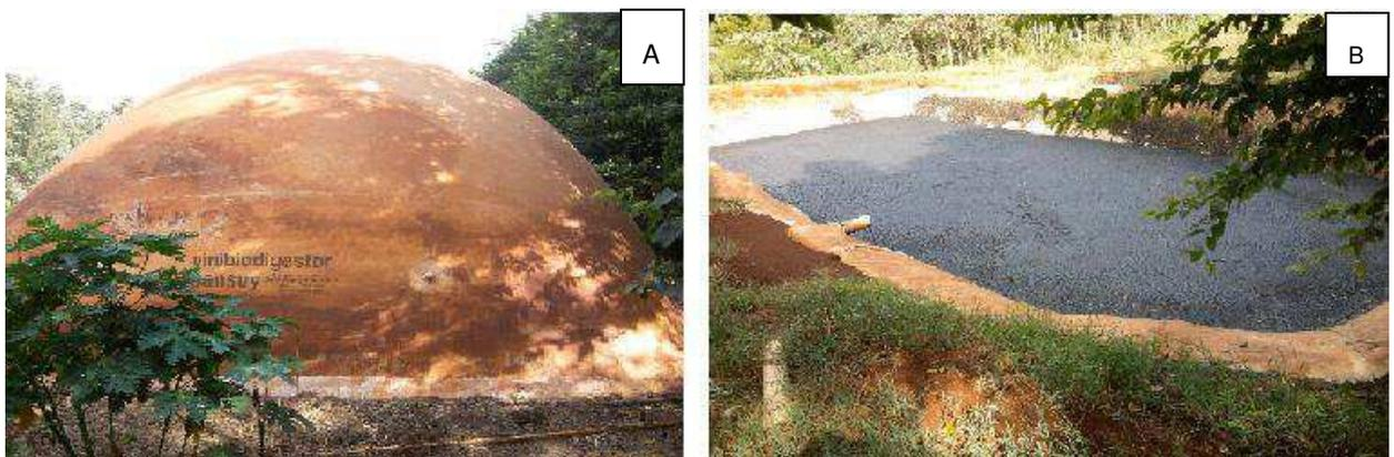
Figura 2. Sistema de tratamento para dejetos de suínos: biodigestor (A) e lagoa facultativa (B)
