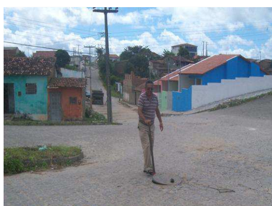
Figura 4.10 – Ponto P4 - Poço de visita da bacia Glória.
