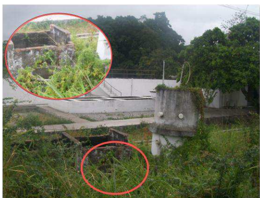
Figura 4.9 – Ponto P3 - Poço de visita da bacia Depuradora.
