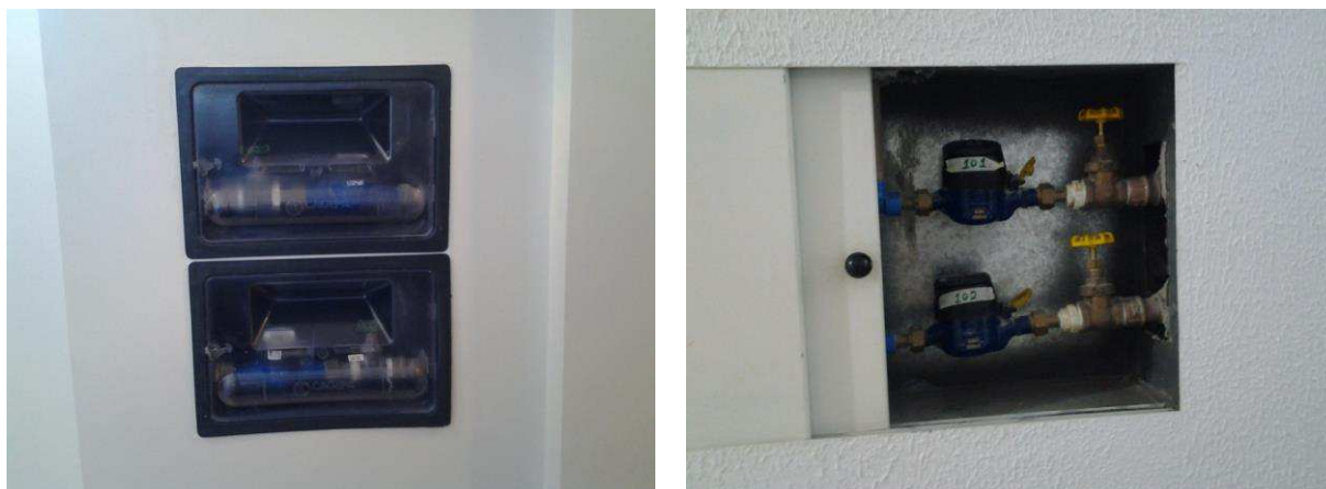
Figura 2.3 – Medidores individualizados de consumo de água
