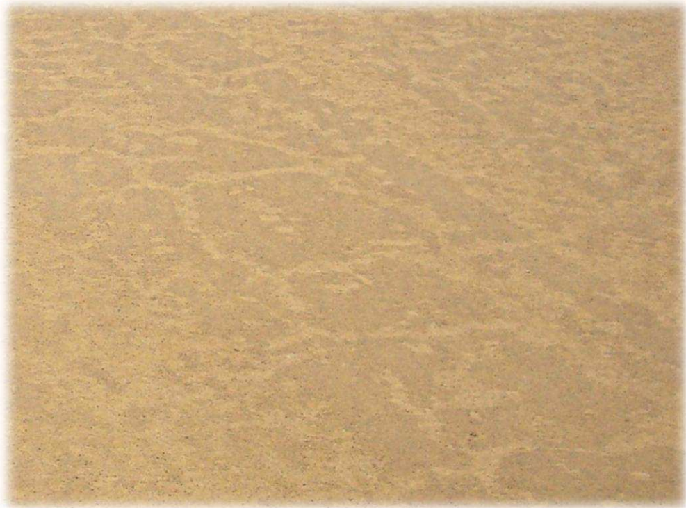
Figura 2.7 - Fissuras em rodovias construídas com Solos Lateríticos Finos [Fonte: Quintans, 2008]
