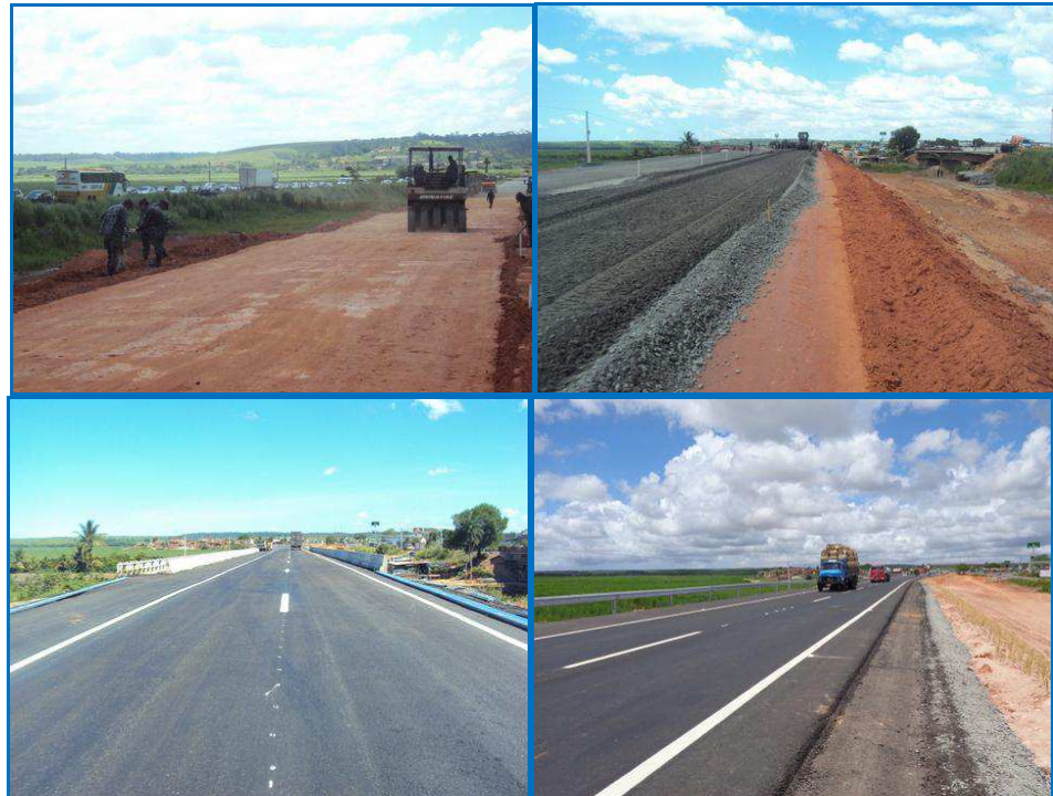
Figura 3.29 – Execução das camadas do pavimento.
