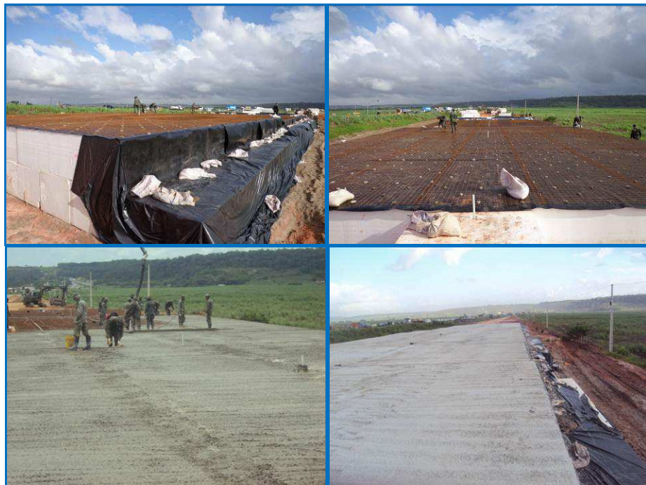
Figura 3.28 – Colocação das mantas, ferragem e concretagem da laje.
