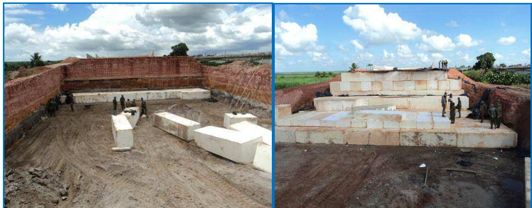
Figura 3.5 – Solução em EPS executada parcialmente feita pelo 3º BEC no Aterro 2.
