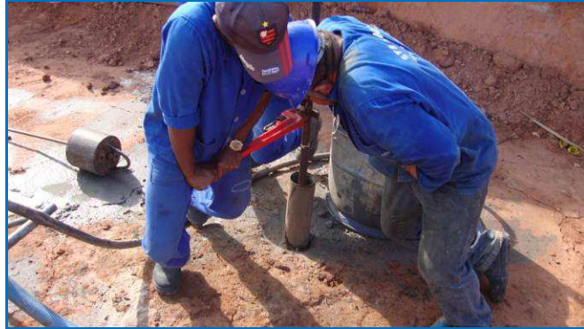
Figura 3.14 - Cravação do conjunto haste de perfuração/amostrador Shelby.
