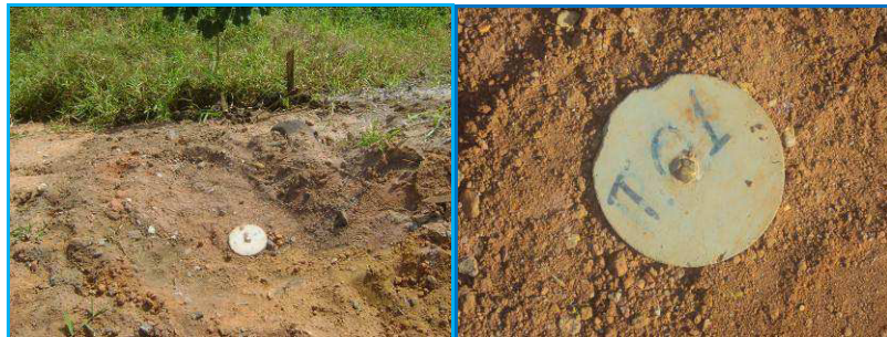
Figura 3.25 - Implantação dos marcos superficiais.
