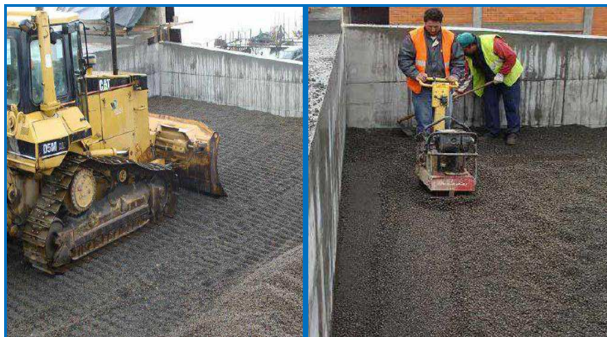
Figura 2.17 – Compactação com trator de esteiras e placa vibratória
