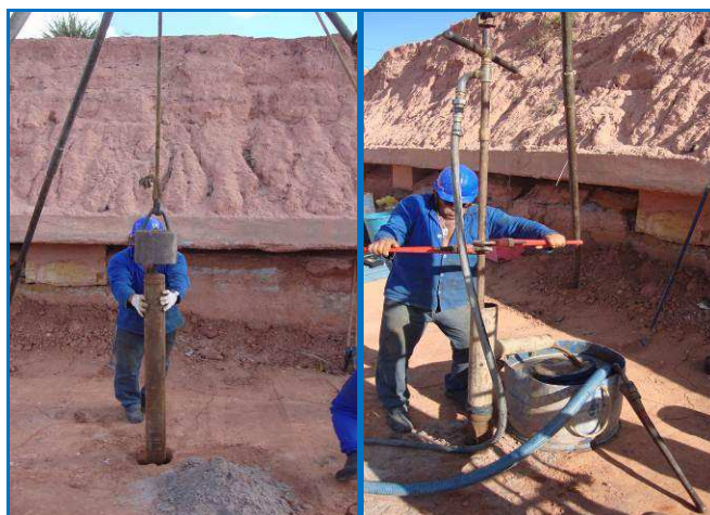
Figura 3.13 - Cravação do tubo de revestimento e lavagem do furo.
