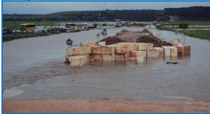
Figura 3.6 – Blocos de EPS do Aterro 2 flutuando.
