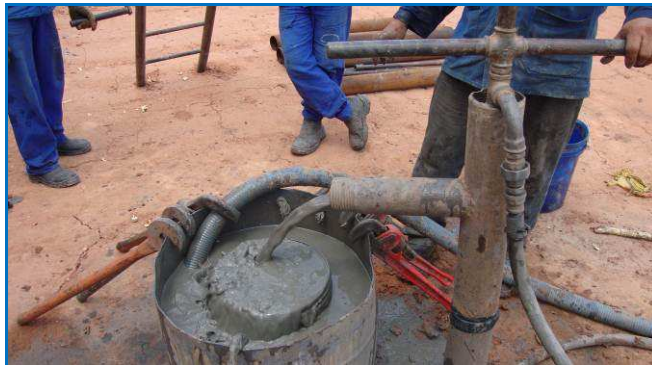
Figura 3.16 - Limpeza e revestimento do furo com lama tixotrópica.
