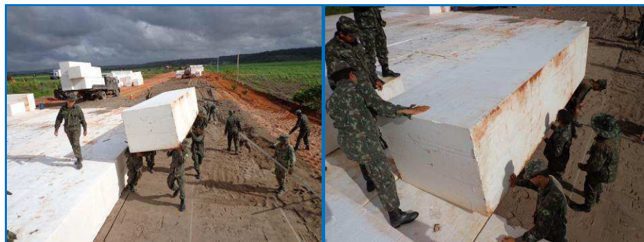
Figura 3.27 – Colocação dos blocos de EPS no Aterro 2.
