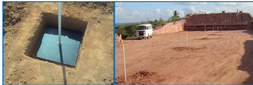
Figura 3.24 - Implantação das placas de recalque.
