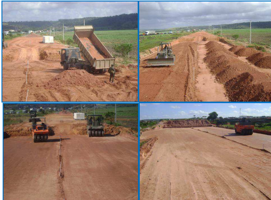
Figura 3.26 – Construção do aterro em argila no Aterro 2.
