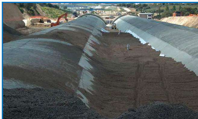
Figura 2.15 – Túnel M50, Madrid, Espanha.
