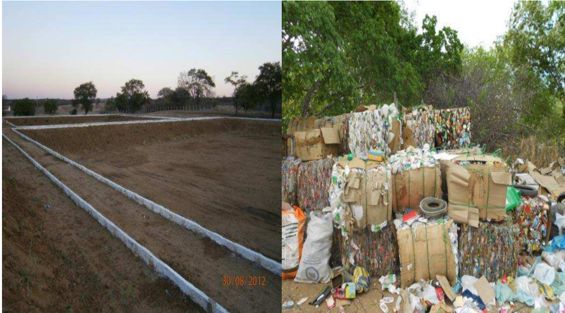
Figura 11 - Fase de construção do aterro sanitário e materiais para reciclagem
