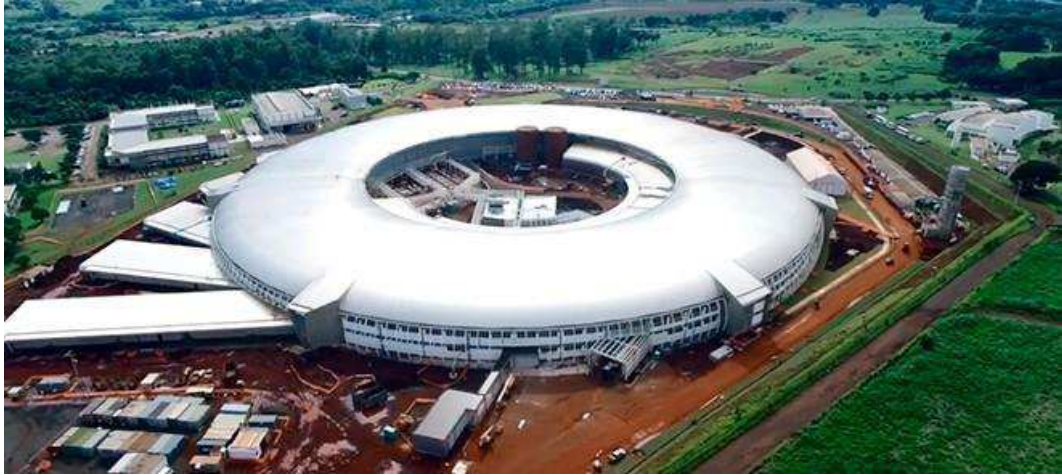
Figura 17. Fotografia do Sirius com primeira etapa concluída
