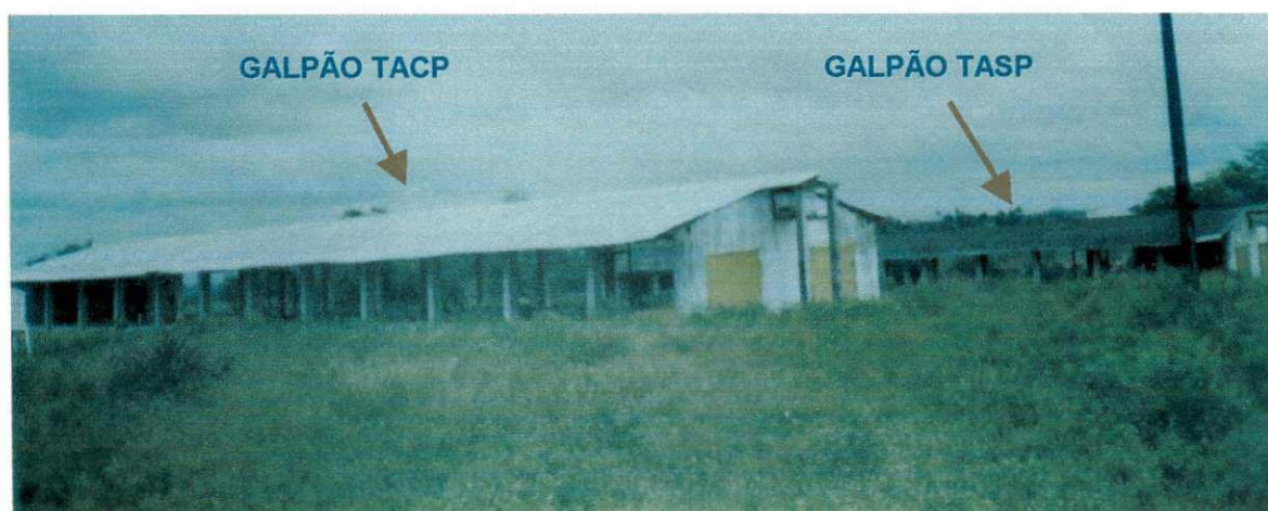
FIGURA 3.1 – Diferença entre os galpões TASP (coberto com telha ondulada) e TACP (pintado com demão de tinta acrílica de cor branca).
