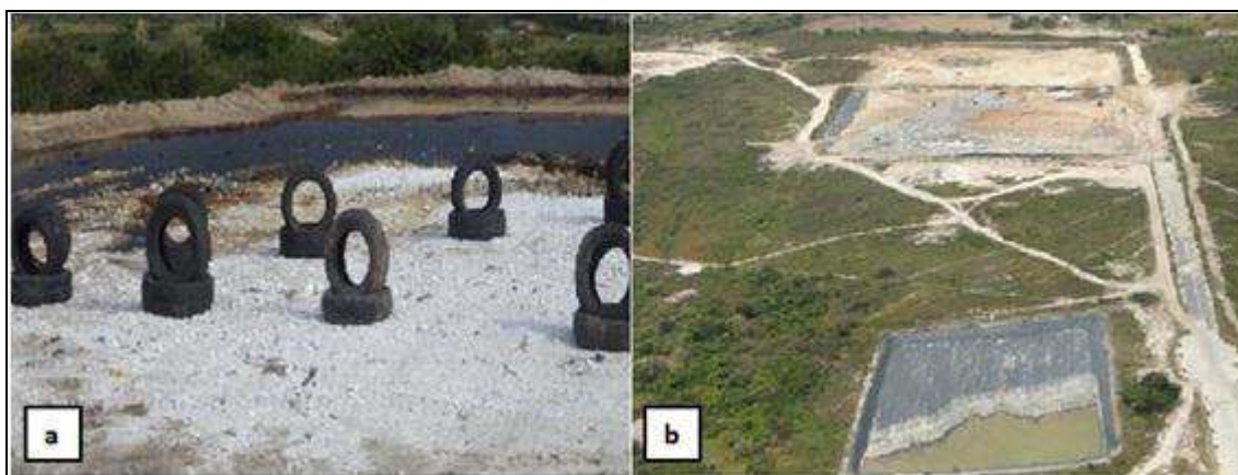
(a) Poças de lixiviado no maciço do aterro e (b) lagoa de retenção do chorume vazia.
