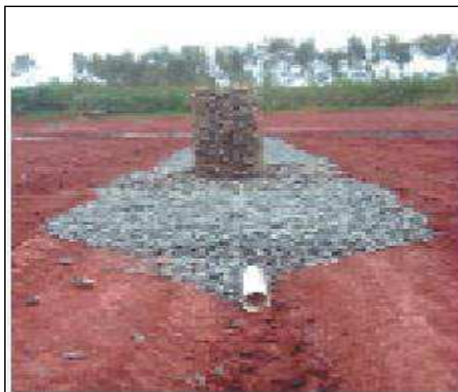
Figura 6- Sistema de drenagem de lixiviado.
