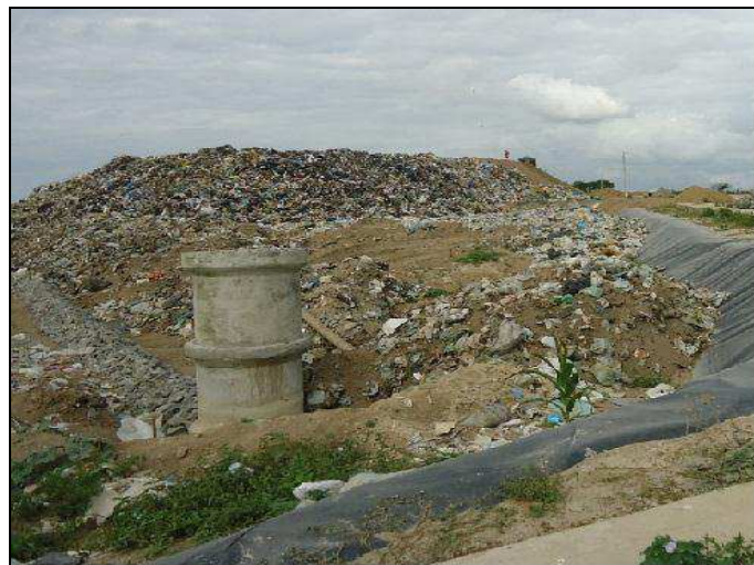
Figura 14 – Dreno de gás no aterro sanitário de Puxinanã-PB.
