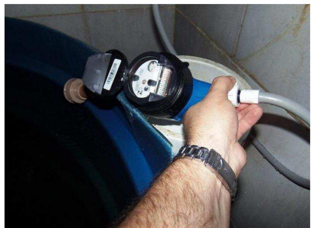
Figura 6. Quantificação de água por meio de hidrômetro Elster AMG-09. Fonte: Própria
