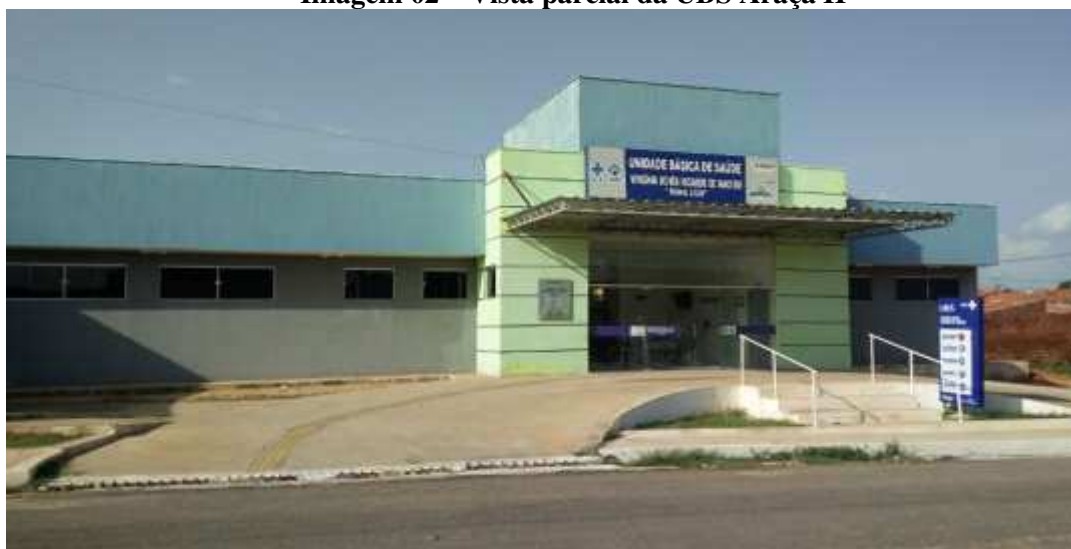
Imagem 02 – Vista parcial da UBS Araçá II
