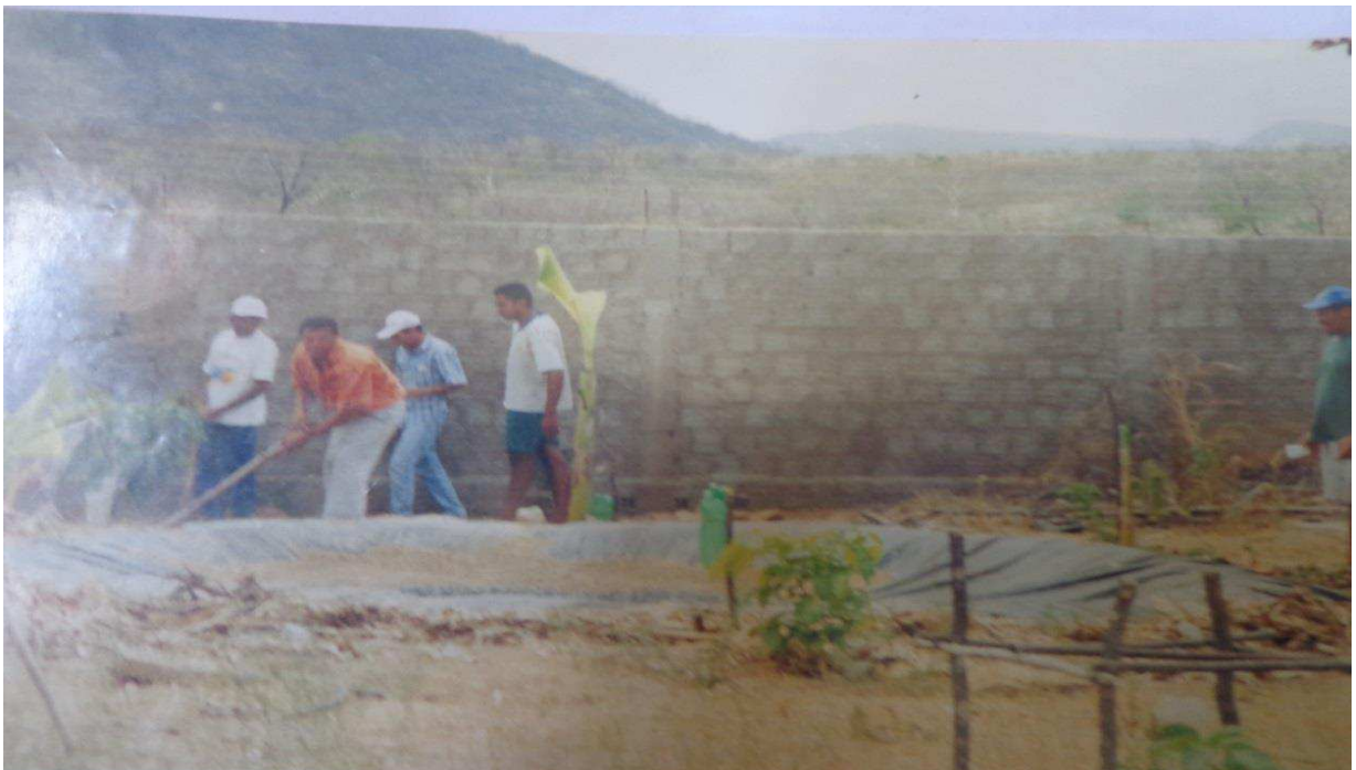
Foto 3 – A construção do Mandalão
