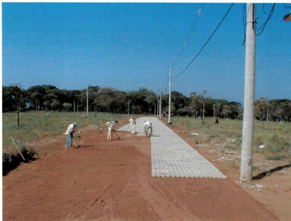
FIGURA 19 – Execução do pavimento após a camada de areia
