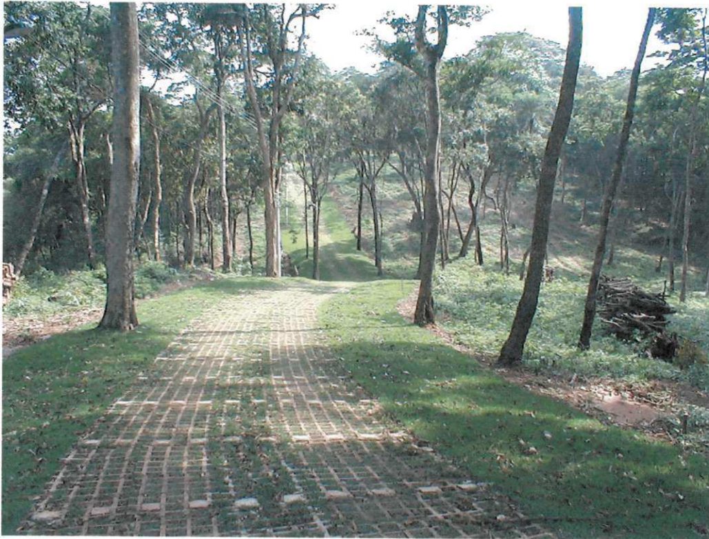
FIGURA 24 – Pista executada em terreno com declive de 5% a 10%
