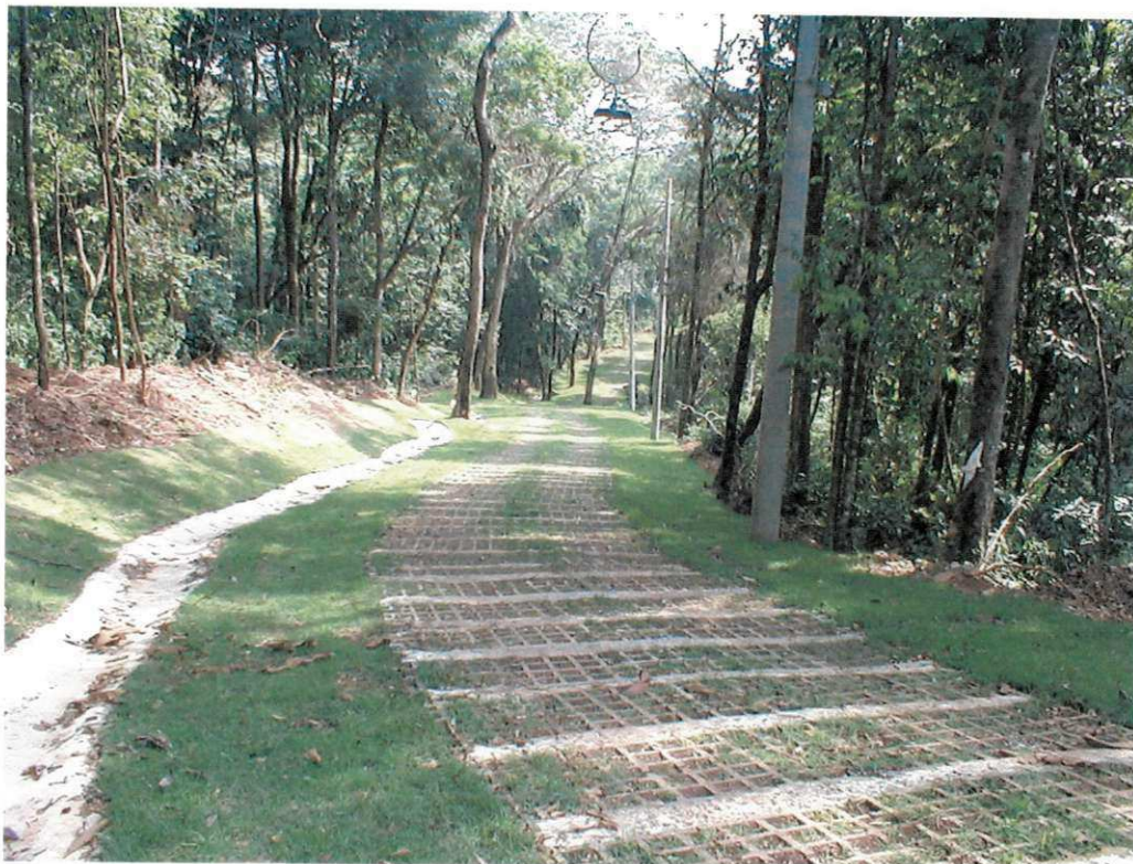
FIGURA 26 – Pista executada em terreno com declive > 10%
