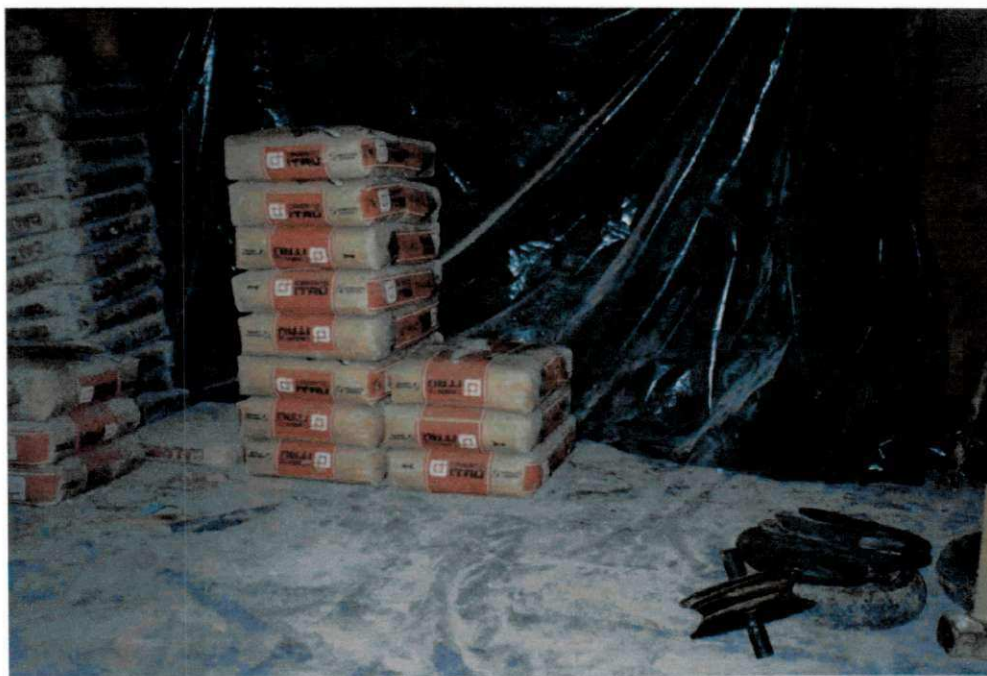
FIGURA 10 – Barracão de estocagem de cimento
