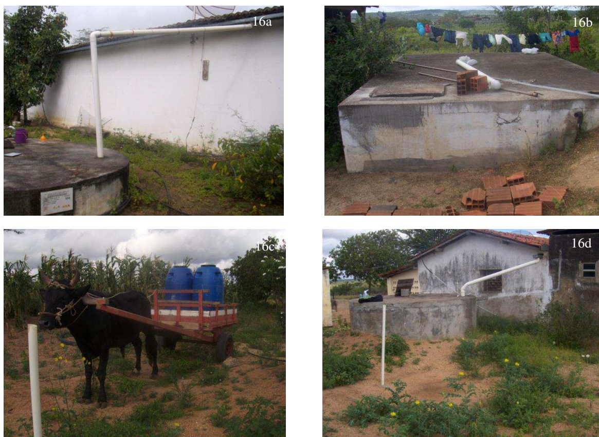
Figura 16 a, b, c e d - (a) Calhas/cisternas de captação; (b) Cisterna quadrada; (c) Carroça de boi e tonéis; (d) Captação e armazenamento.
