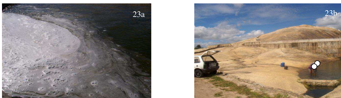
Figura 23 a e b – (a) Tanque parte alta; (b) Tanque/intervenção antrópica. Fonte: Dados da pesquisa, (2014).
