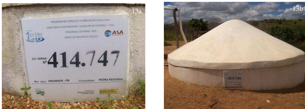
Figura 13 a e b - (a)Placa de identificação; (b) Cisterna de placas. Fonte: Dados da pesquisa, (2014).
