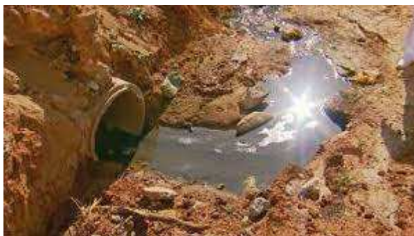
FIGURA 21: Esgoto eliminado a céu aberto Fonte: Própria autora, 2014.
