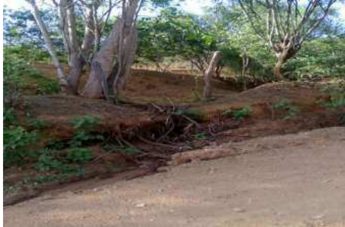
FIGURA 39: Erosão Fonte: Própria autora, 2014.
