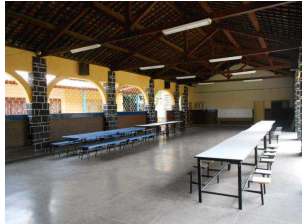
Figura 6 - Visão do pátio interno que serve como mini refeitório para os estudantes. Fonte: ABREU, 2014.
