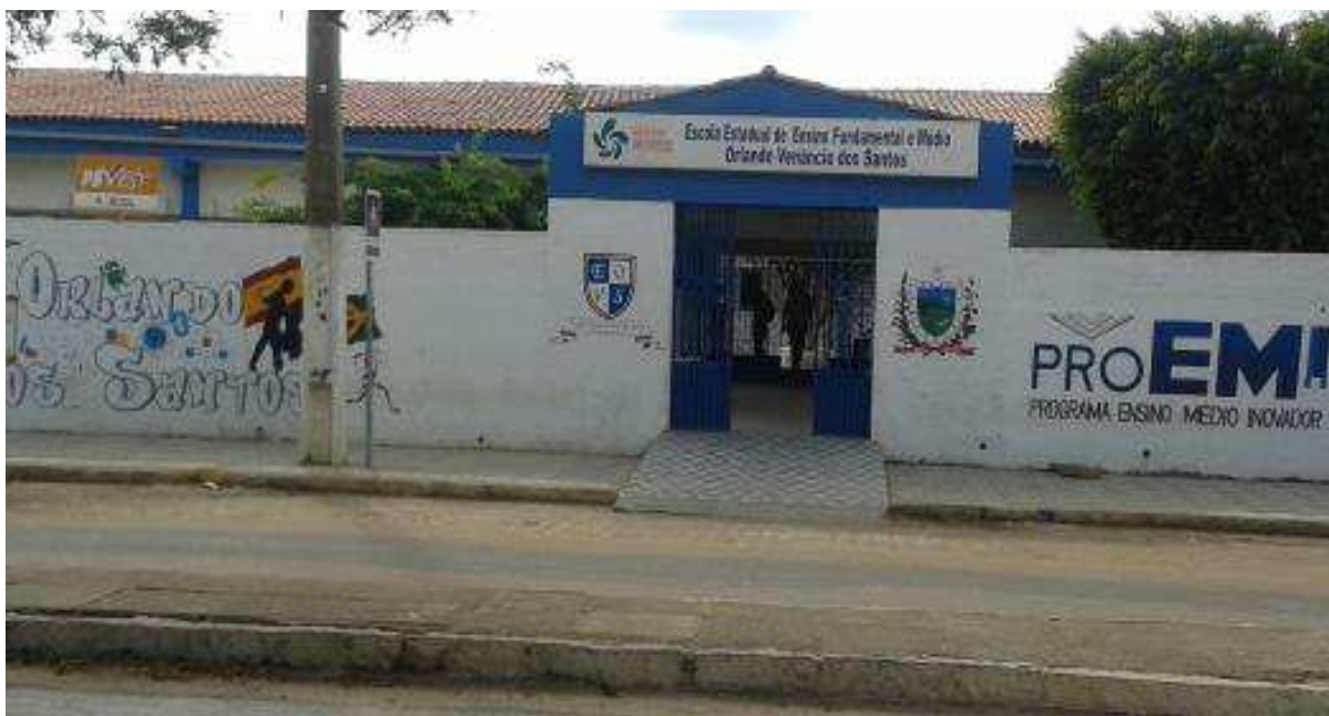
Figura 1. Fachada da escola campo de pesquisa – E.E.E.M. Orlando Venâncio dos Santos, município de Cuité-PB, 2014.
