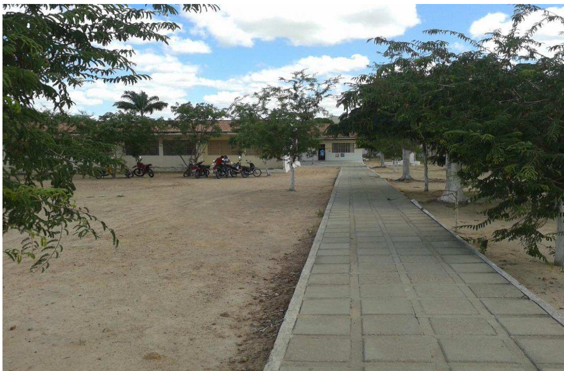
FIGURA 1 - vista da área interna parcial da Escola Estadual de Ensino Fundamental e Médio, Barra de Santa Rosa-PB, 2015.
