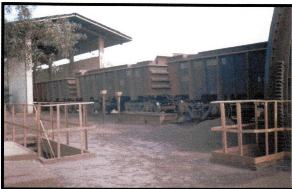
FIGURA 26 – DESEMBARQUE :VIRADOR DE VAGÕES (TERMINAL MARÍTIMO DE PONTA DA MADEIRA, CVRD, 2001)
