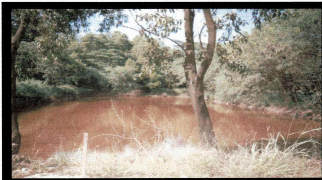
FIGURA 33 - LAGOA DE DECANTAÇÃO (TERMINAL MARÍTIMO DE PONTA DA MADEIRA, CVRD, 2001)
