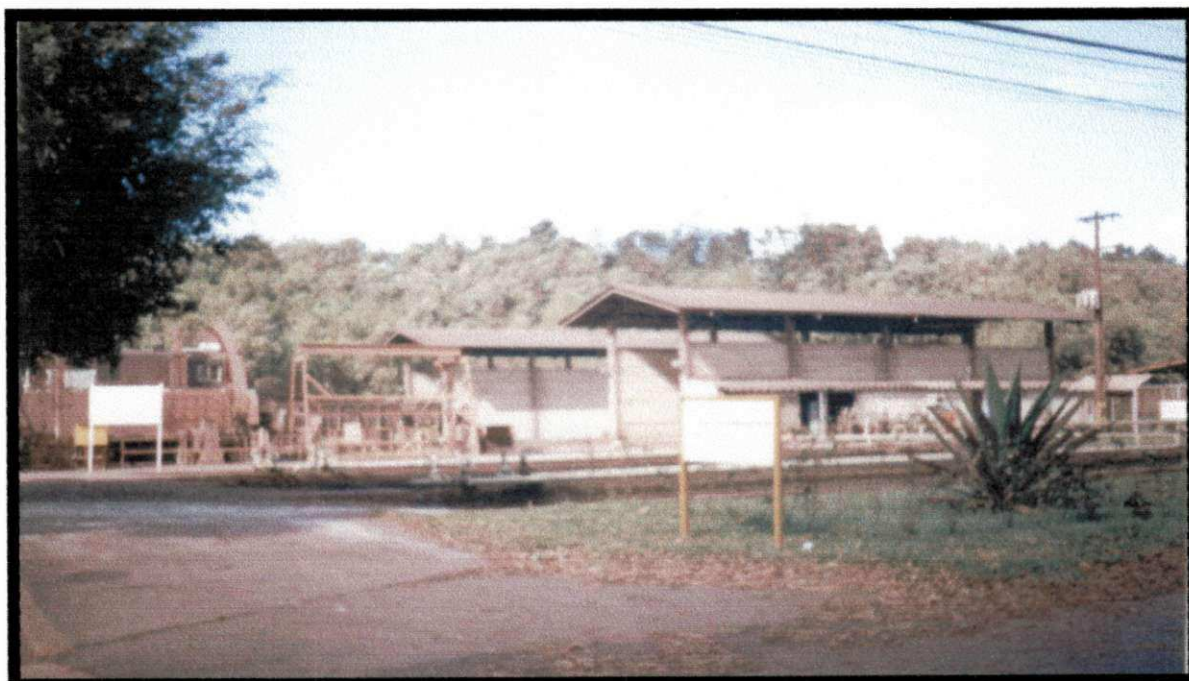
FIGURA 25 – BACIA DE DECANTAÇÃO (TERMINAL MARÍTIMO DE PONTA DA MADEIRA, CVRD, 2001)
