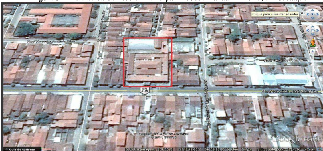
Figura 5 - Vista aérea da Escola Municipal Dr. José Dantas Pinheiro, em destaque
