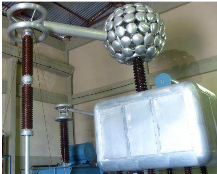
Figura 26 - Fotografia do transformador a ser utilizado nos ensaios.
