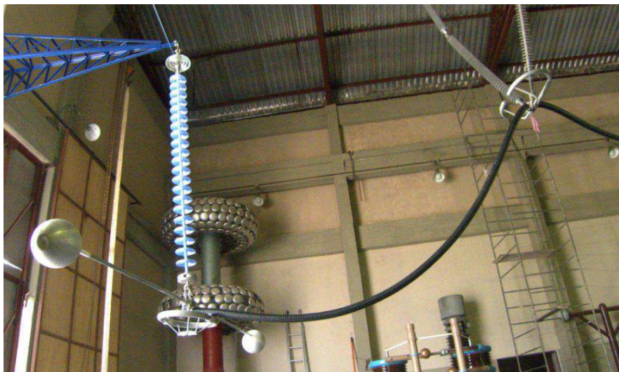
Figura 30 - Fotografia do arranjo para medição da radiação UV.
