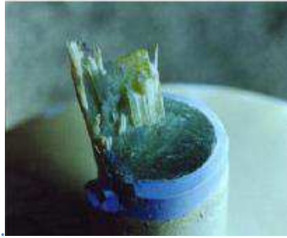
Figura 10- Fratura frágil em isolador polimérico.
