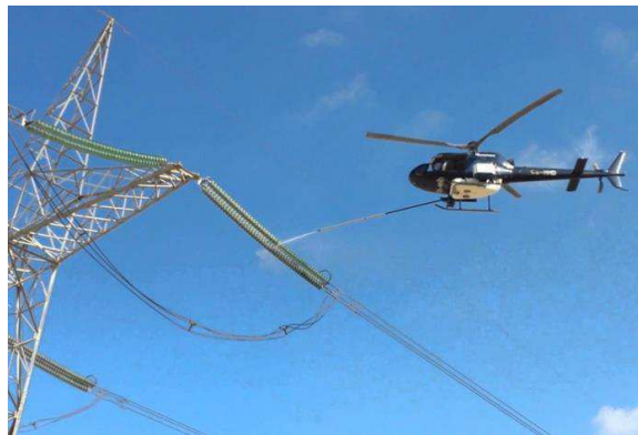
Figura 5 - Fotografia da lavagem de isoladores em linha de transmissão.
