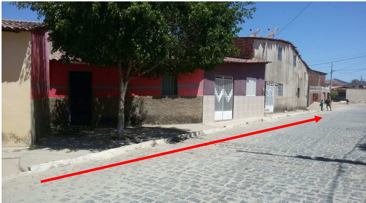
Fotografia 9- Desalinhamento das casas na Rua José Martins de Oliveira, bairro São Francisco
