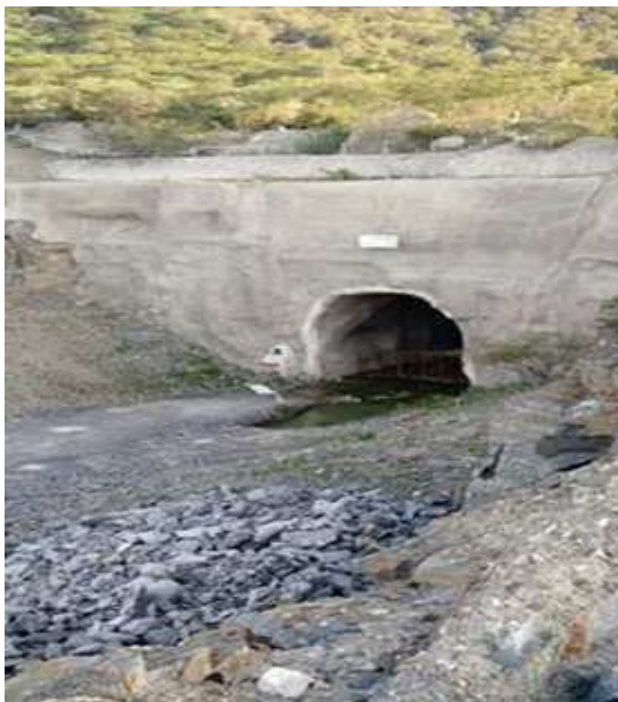
Fotografia 4 - Túnel de Cuncas II
