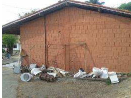
Figura 20: Resíduos de construção e demolição. Fonte: Sara Pontes, 2014
