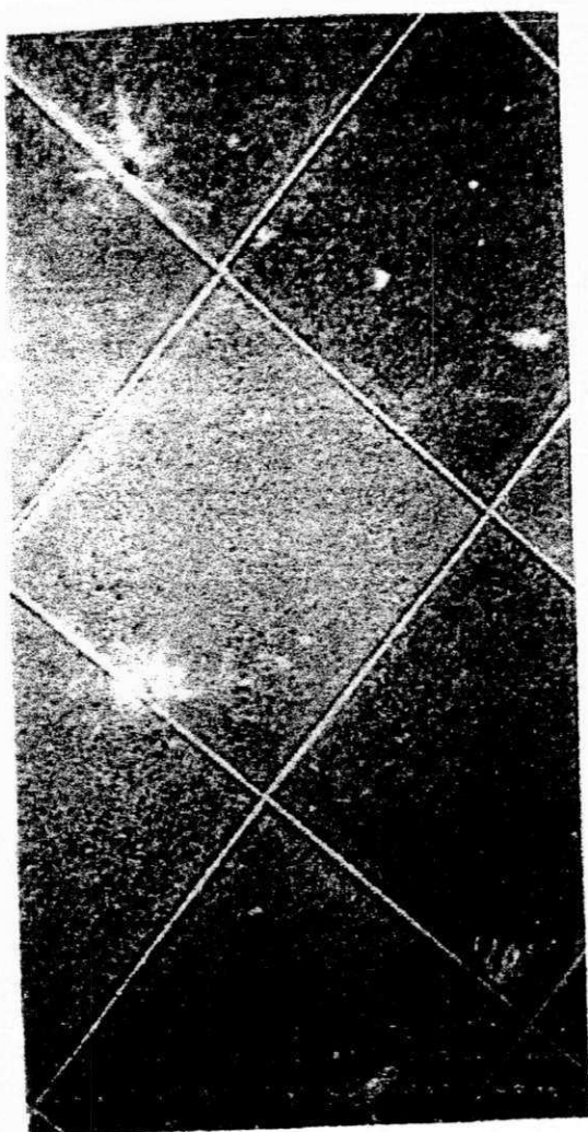
Figura 26 - Aspectos de Eflorescências em Piso Cerâmico em Casa Residencial na Cidade de Campina Grande - PB.
