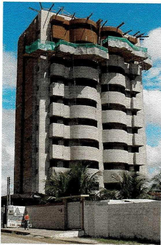
Figura 3.3 – Edifício Guarujá V – fase de revestimento.
