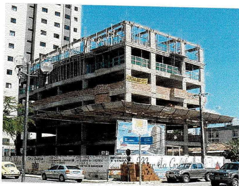
Figura 3.15 – Edifício Mar da Galiléia antes da concretagem da 7ª laje.
