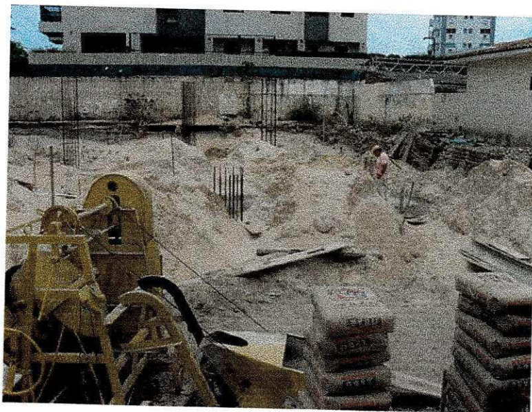
Figura 3.14 – Edifício Mar da Galiléia antes da concretagem dos pilares.
