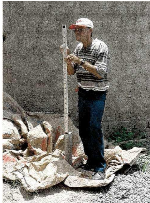
Figura 3.24 – Referência de nível do edifício Guarujá V.
