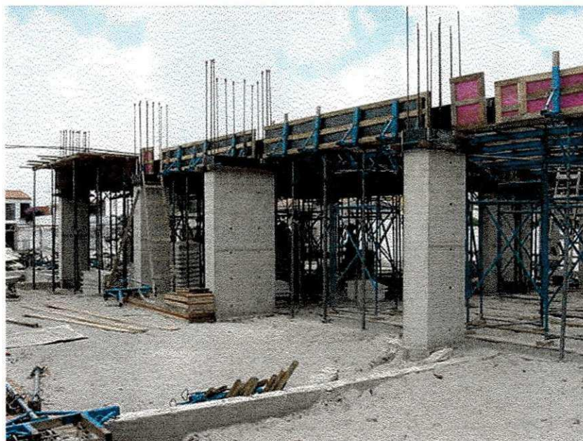
Figura 3.9 – Edifício Irineu Catão antes da concretagem da 1ª laje.
