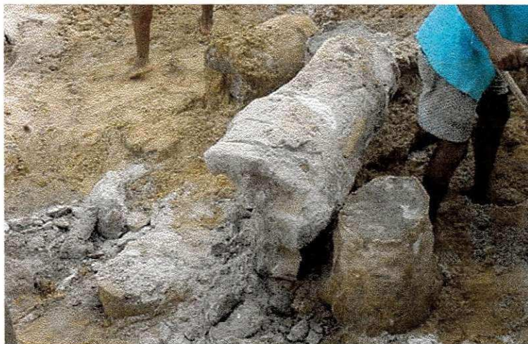
Figura 3.18 – Estaca de areia e cimento.
