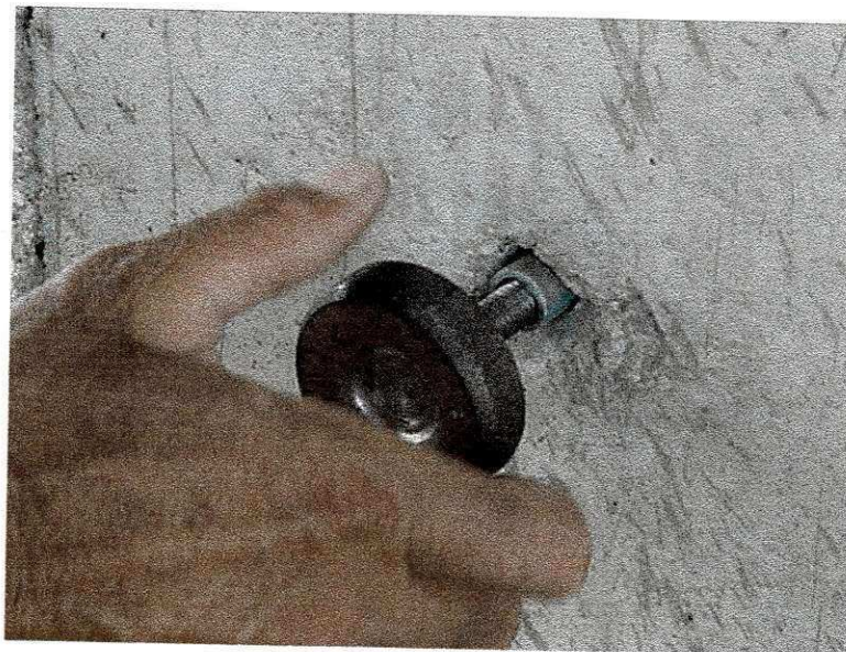
Figura 3.21 – Colocação do pino para se efetuar a medição do recalque.
