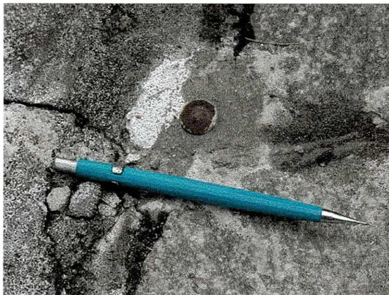
Figura 3.26 – Referência de nível do edifício Mar da Galiléia.
