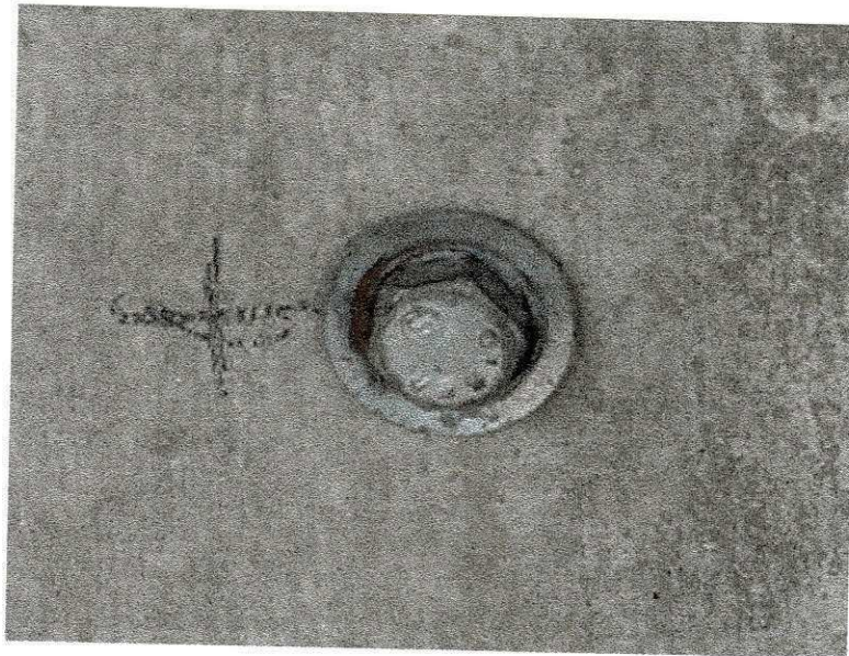
Figura 3.20 – Parafuso fixado no pilar.
