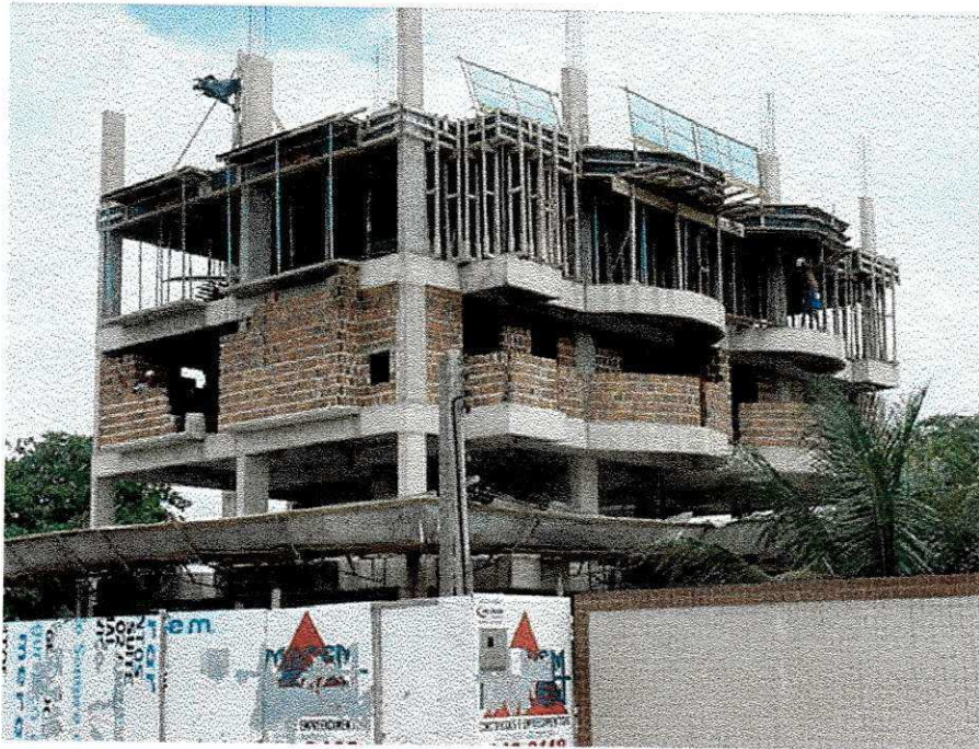
Figura 3.2 – Edifício Guarujá V com 4 lajes concretadas.
