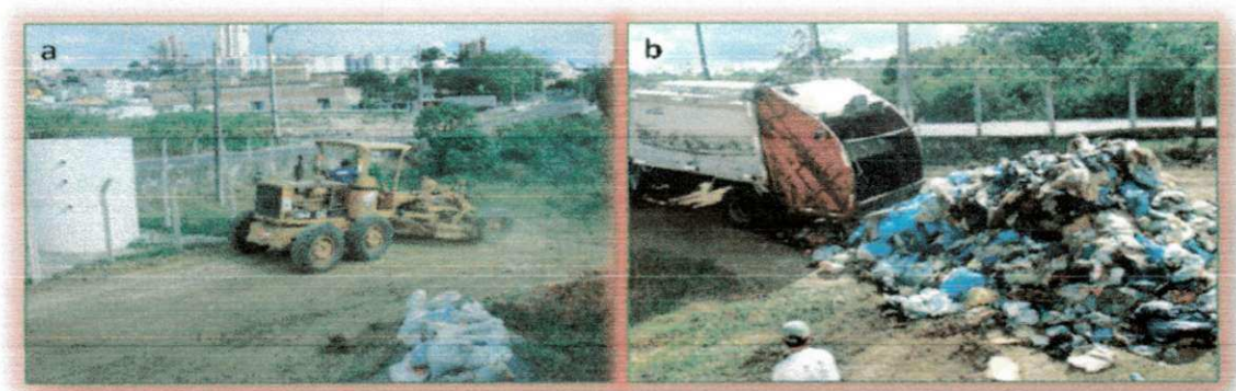
Figura 10: (a) Regularização do terreno; (b) Descarregamento dos resíduos
