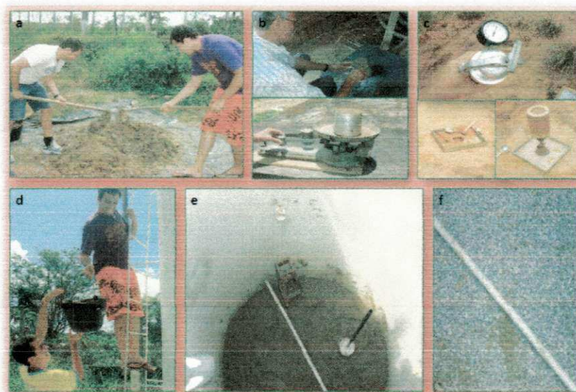
Figura 14: (a) Preparação do solo para; (b) Ensaio do solo in situ; (c) Ensaio de umidade e densidade in situ; (d) Preenchimento da camada de base; (e) Compactação do solo; (f) Camada de brita e dreno de percolação
