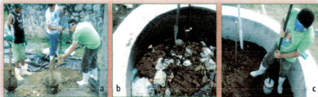
Figura 16: Camada de cobertura: (a) preparação do solo; (b) e (c) Compactação da camada de cobertura
