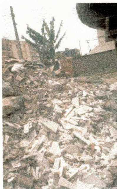
FIGURA 4.40-Deposição do entulho na própria construção
