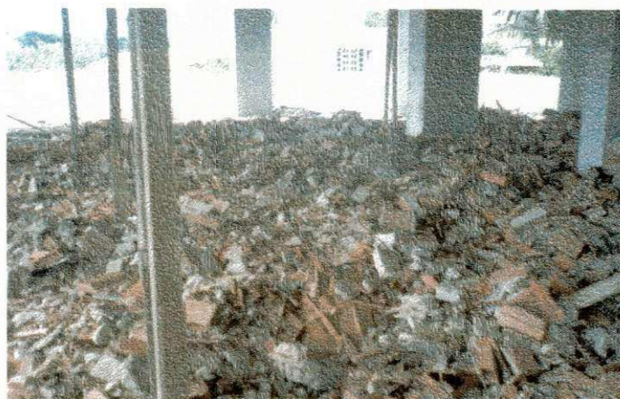
FIGURA 4.38- Resíduo de tijolo e argamassa
