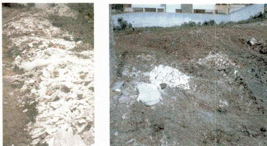
FIGURA 4.43- Deposição de gesso
