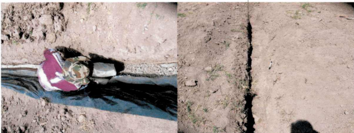
Figura 3.10 – Isolamento dos blocos e profundidade dos drenos
