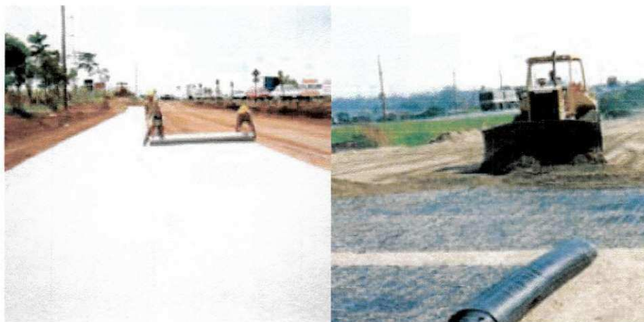
Figura 2 – Reforço de base de pavimentos com geossintéticos.
