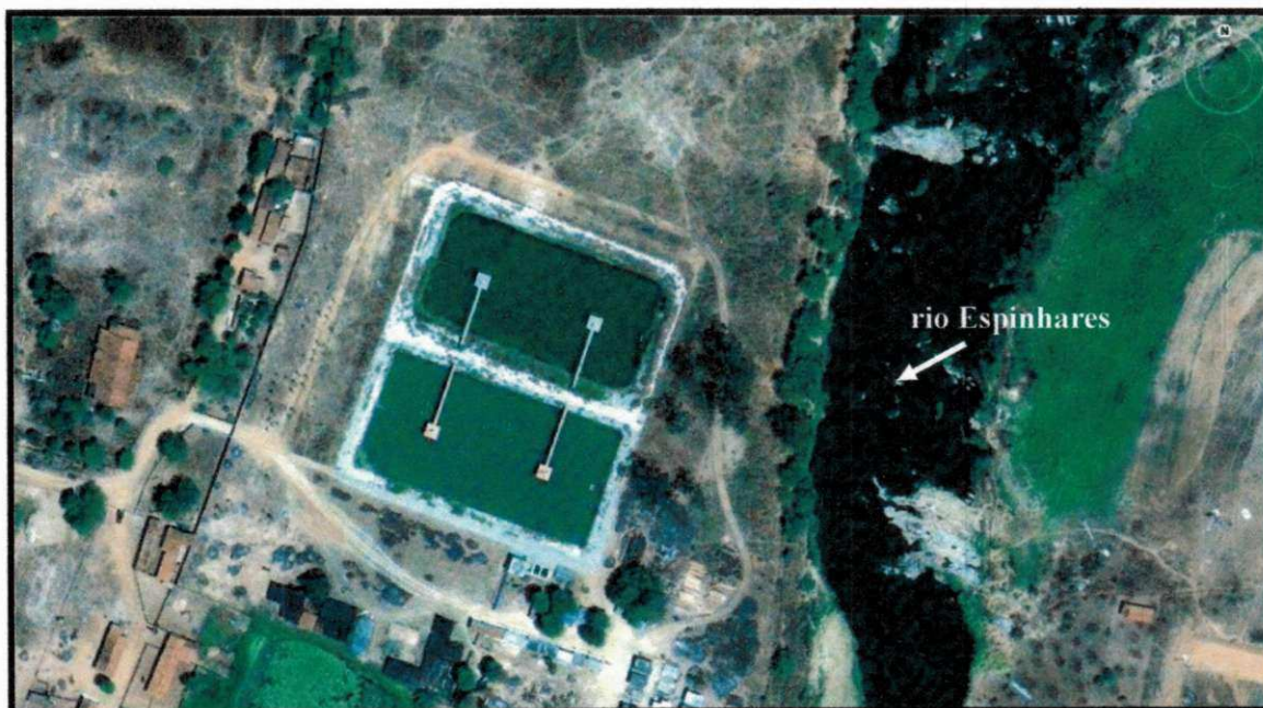
Figura 4.6 - Vista aérea da ETE de Patos (Patos - PB), em 10 de outubro de 2009. Fonte: Google Earth.
