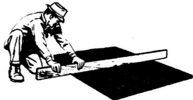
Figura P69 - Preenchimento da pannela com pré-misturado a frio
