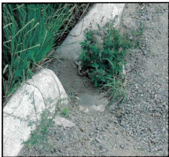
Figura D151 - Entupimento das sarjetas [Local: Av. Januncio Ferreira, Campina Grande-PB]
