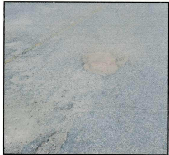
Figura P71 - Nível de severidade médio
