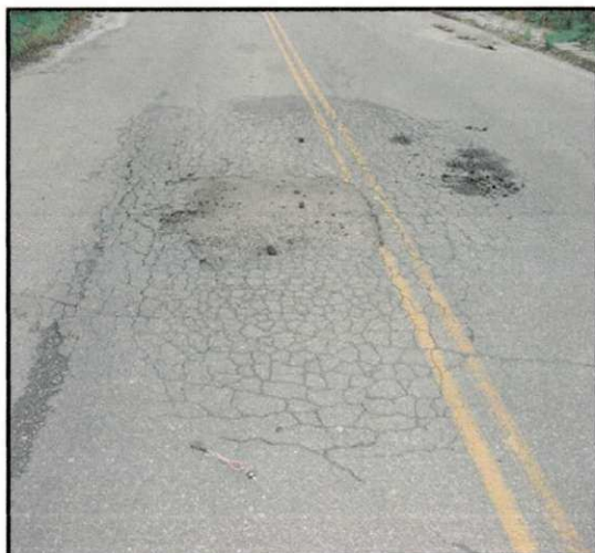
Figura T18 - Nível de severidade Alto
