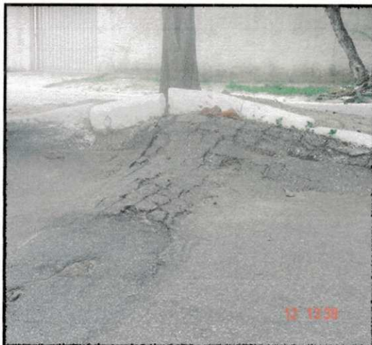
Figura S120 - Nível de severidade alto
