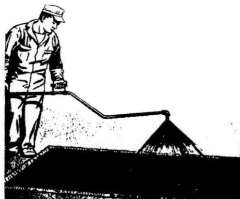
Figura 3.6 - Aplicação de ligante asfáltico (Fonte: DNER)
