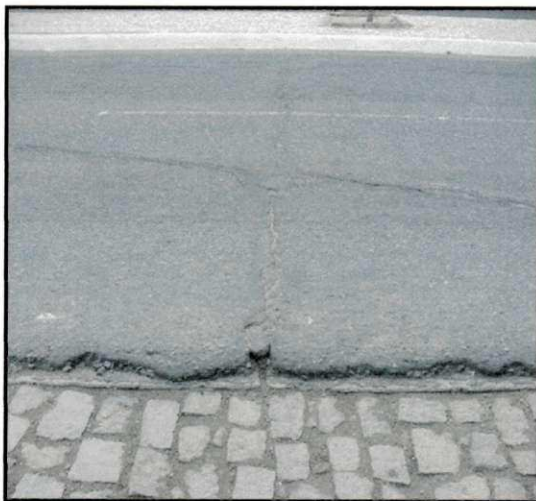
Figura T42 - Nível de severidade alto
