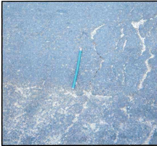
Figura T22 - Nível de severidade baixo
