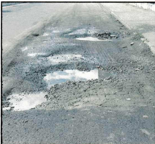
Figura D162 - Nível de severidade alto
