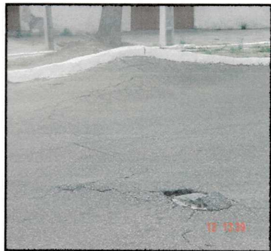
Figura S119 - Nível de severidade médio
