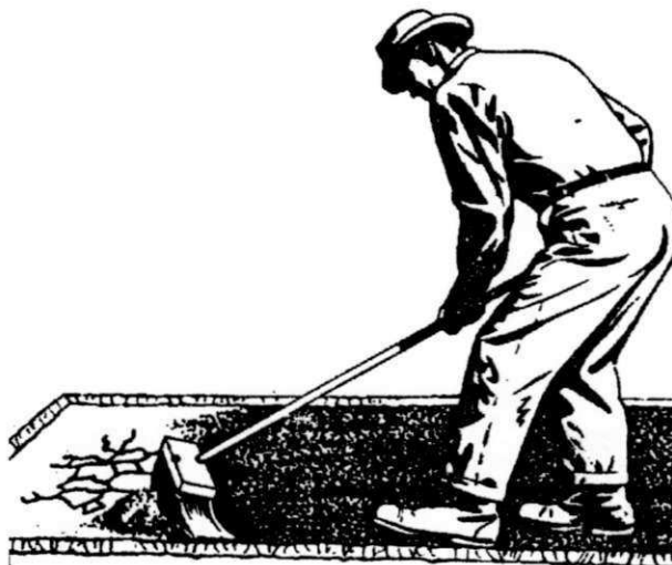
Figura T9 – Selagem das trincas com lama asfáltica (Fonte: DNER)
