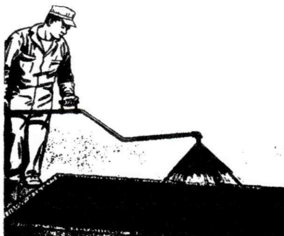
Figura S87 - Aplicação de ligante asfáltico (Fonte: DNER)
