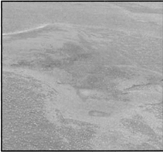
Figura R49 – Remendos com escorregamento da mistura asfáltica [Local: Rua Republica, Campina Grande-PB]
