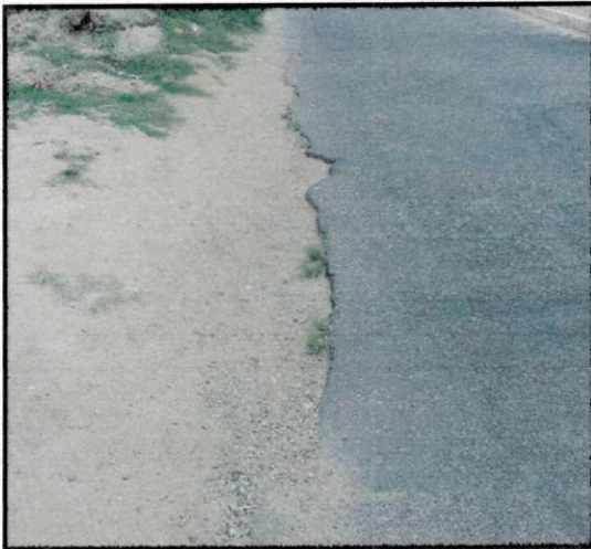
Figura S109 – Desintegração do bordo
