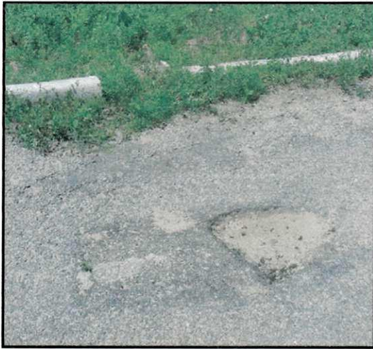
Figura P70 - Nível de severidade baixo
