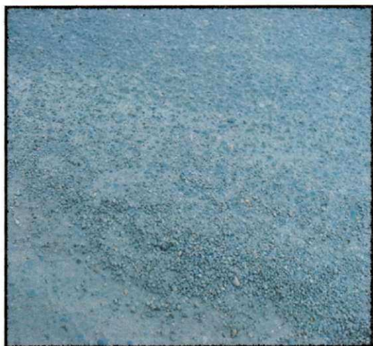
Figura S85 - Desagregação
