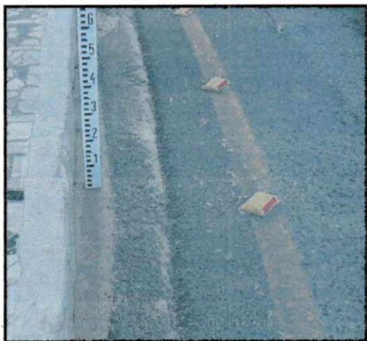
Figura S91 - Sobreposição de camadas [Local: Anel viário do Alto Branco, Campina Grande-PB]
