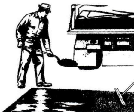
Figura S123 - Execução do remendo com PMF (fonte: DNER)
