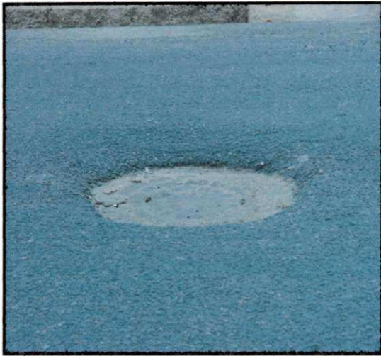
Figura D133 - Afundamento do tampão do poço de visita [Local: Rua Martins Junior, Campina Grande-PB]
