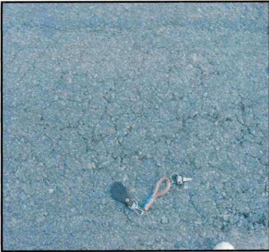
Figura T4 - Nivel de severidade baixo
