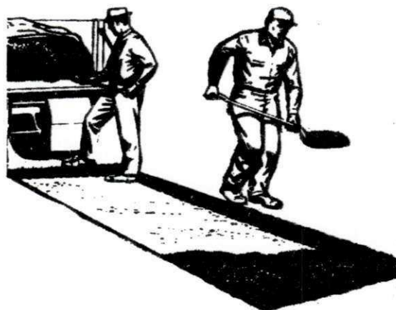
Figura S81 - Execução de novo revestimento com mistura adequada (Fonte: DNER)
