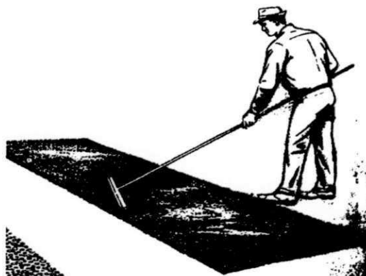
Figura T39 - Colocação de Lama asfáltica (Fonte: DNER)
