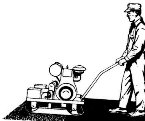
Figura R63 - Compactação adequada para superfície do remendo (Fonte: DNER)
