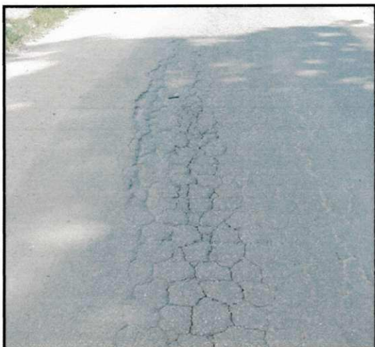
Figura T1 - Trincas por fadiga em trilhas de rodas [Local: Rua João Quirino, Campina Grande-PB]
