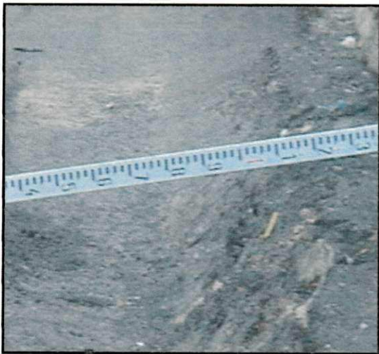
Figura S78 - Nível de severidade alto
