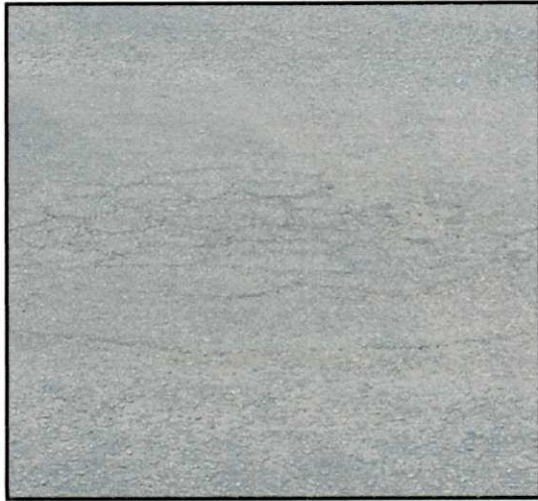
Figura T16 - Nível de severidade baixo
