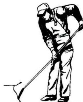
Figura T21 - Aplicação de selante
