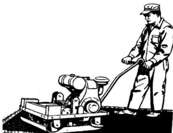
Figura R57 - Compactação adequada para a superfície do remendo (Fonte: DNER)
