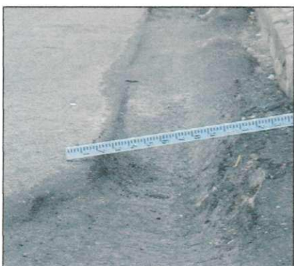
Figura 3.5 – Nível de severidade alto
