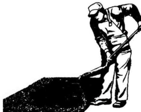
Figura T27 – Aplicação de emulsão asfáltica (Fonte: DNER)
