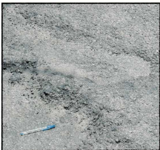
Figura S79 - Envelhecimento da mistura asfáltica [Local: Av. Almirante Barroso, Campina Grande-PB]
