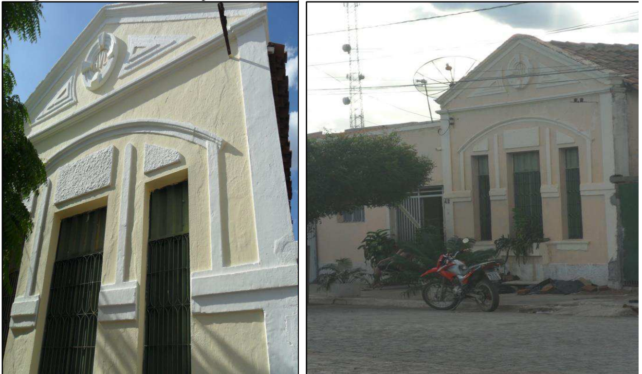
Figura 6 – Detalhe da casa do aposentado José Leoncio
