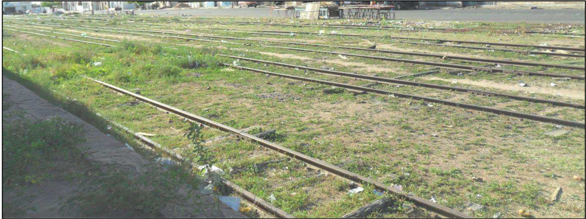
Figura 22 – Trilhos, parte da frente da estação
