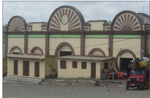
Mercado Público que ainda conserva a tipologia original. Ano 1916.
