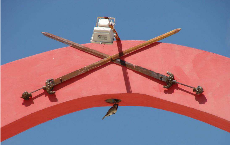
Figura 20: Detalhe das espadas no arco do Memorial da Confederação do Equador , 2015.
