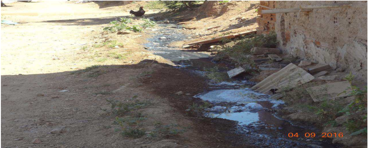
Foto 5 – Esgoto a céu aberto nas vias públicas não pavimentadas do bairro Luiz Ferreira
