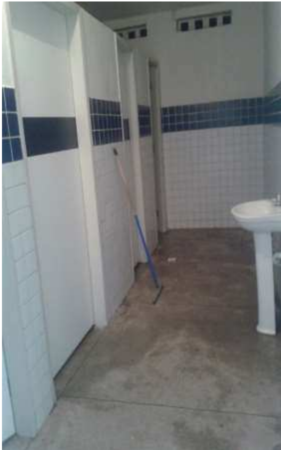
Fotografia 06 – Banheiro dos Professores
