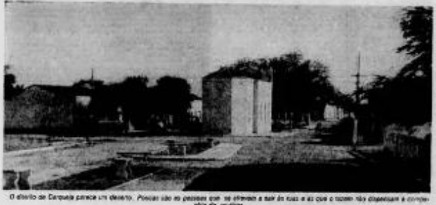
O edifício de Carqueja parecia um deserto. Poucos são os passantes que se atrevem a sair de casa e os que passam são acompanhados por policiais.
