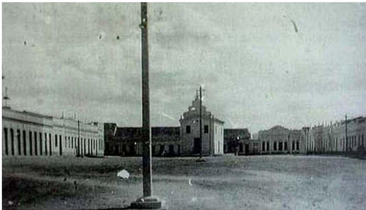
Imagem 97: Rua João Pessoa, atual Praça Agamenon Magalhães, com postes já com lâmpadas elétricas (Fonte: Casa da Cultura de Serra Talhada)
