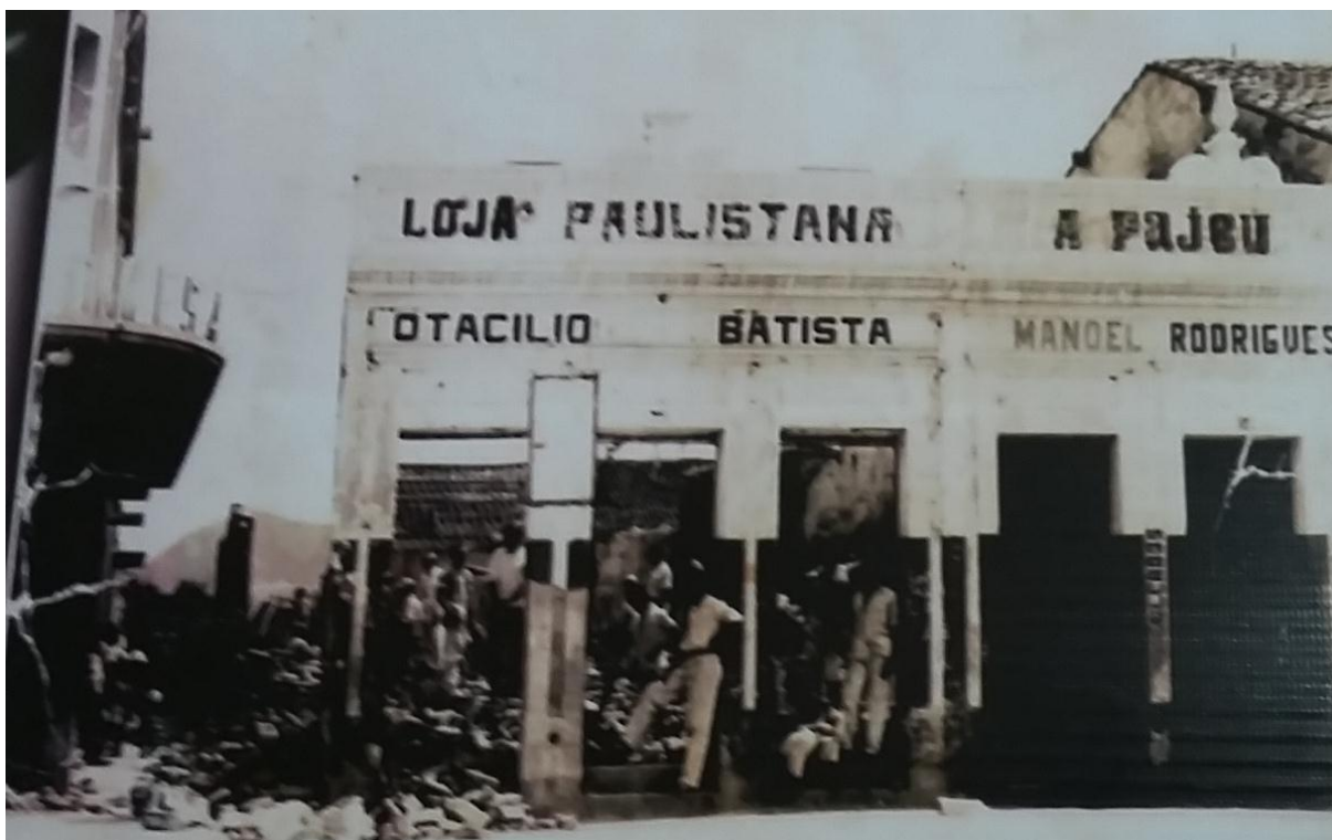
Imagem 45: Demolição da Loja Paulistana, de Otacílio Batista, e da A Pajeú, de Manoel Rodrigues, que ficavam na Praça Sérgio Magalhães. (Fonte: Casa da Cultura de Serra Talhada)
