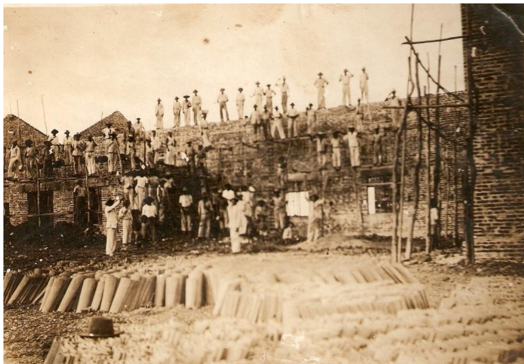
Imagem 68: Construção do Mercado Público de Serra Talhada (Fonte: Professor Dierson Ribeiro)
