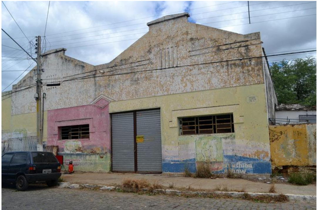
Imagem 32: Antigo prédio da SANBRA (Fonte: Alejandro J. García - 2015)
