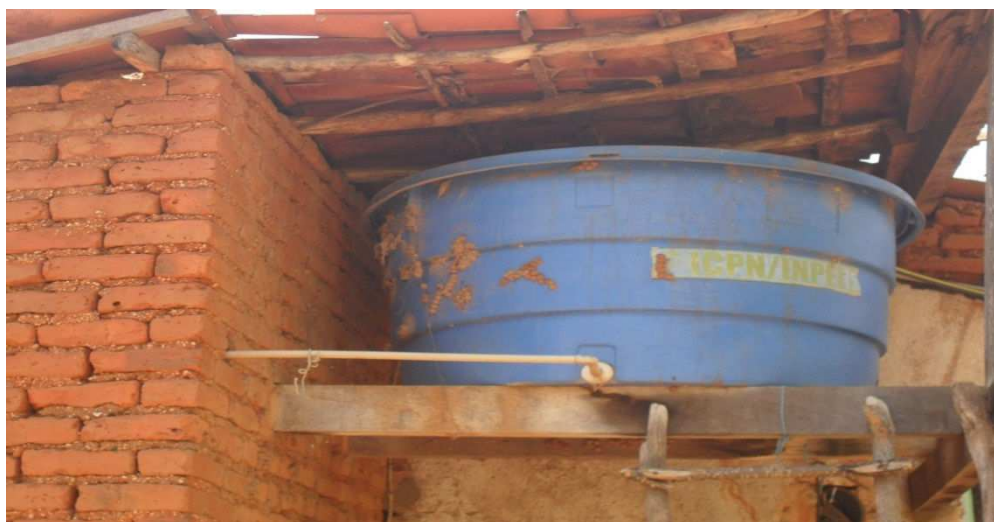
Foto 09 - Armazenamento de água em caixa d'água (Foto: Lidiane G. Dantas, 20/05/2011).
