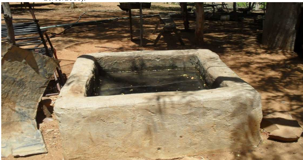
Foto 12 - Armazenamento de água em tanque de alvenaria (Foto: Lidiane G. Dantas, 20/05/2011).
