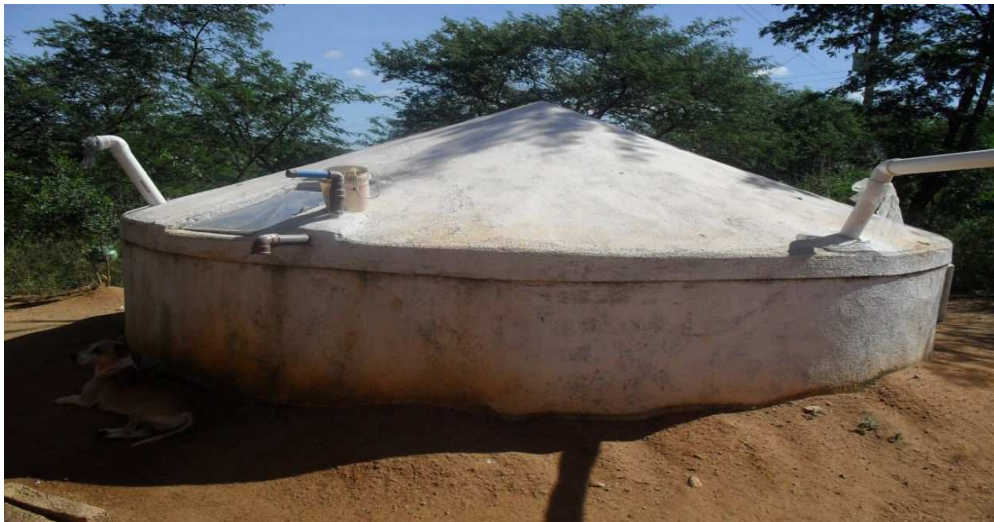
Foto: 10- Armazenamento de água em Cisterna de Placa (Foto: Lidiane G. Dantas, 20/05/2011).
