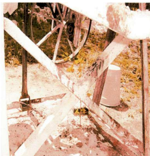
Figura 16 - Fotografia do sistema de barra de estabilização fixa.
