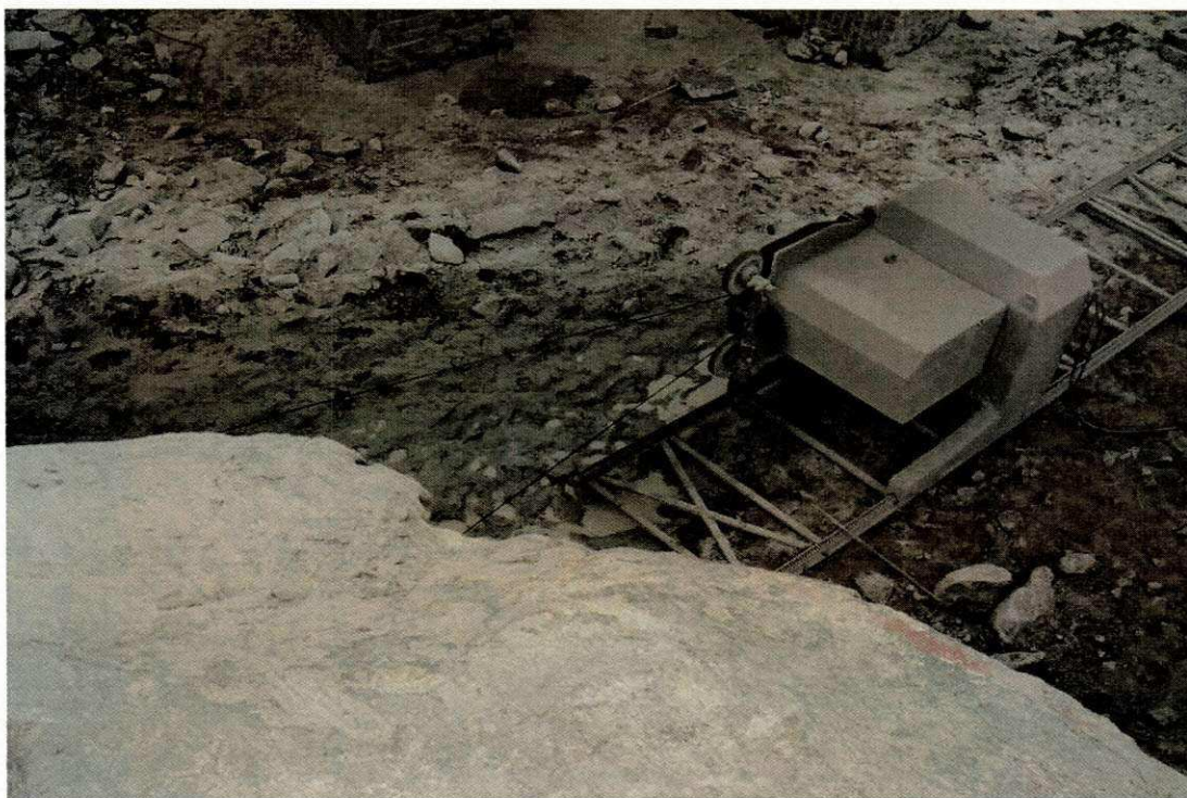
Figura 2.12: Operação de corte com fio diamantado em uma pedreira de granito localizada em Santa Luzia – PB.
