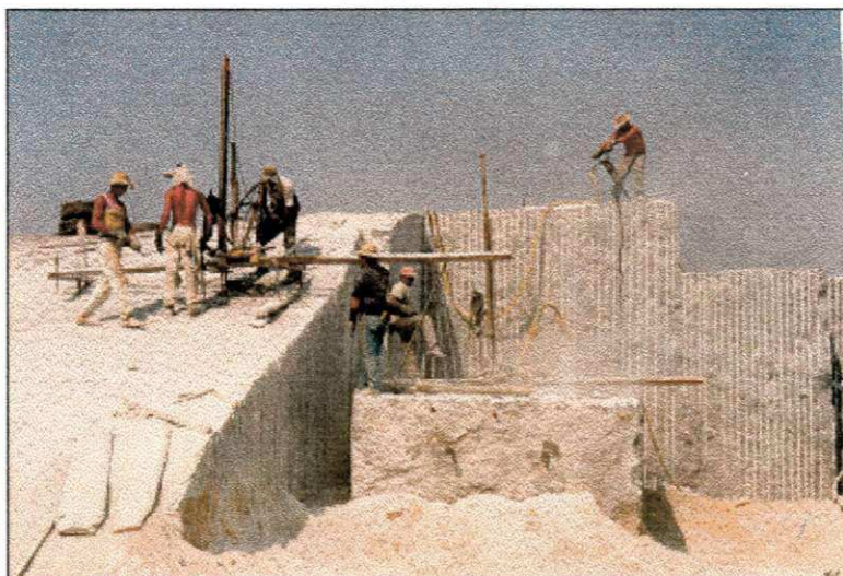
Foto 3.8- Uso de talha-bloco e cunha pneumática de desmonte, além de desbaste de bloco semi-acabado.
