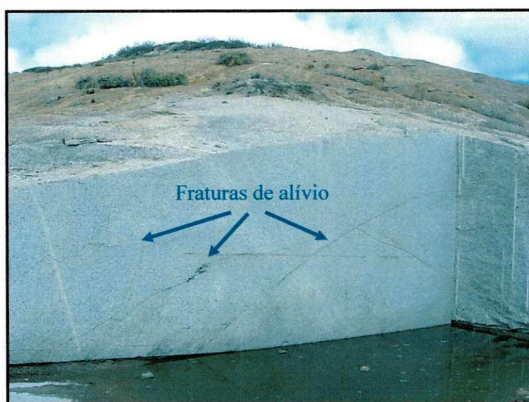
FIGURA 1 – Fraturas decorrentes do alívio de tensão na pedreira localizada em Pocinhos.
