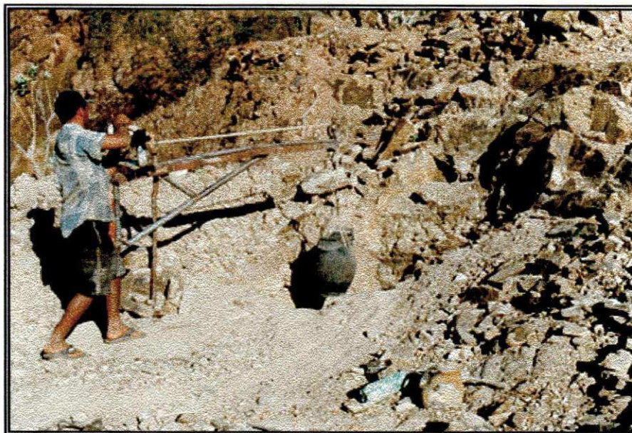
FOTO 7- Tripé com roldana utilizado para içar o minério até a superfície.
