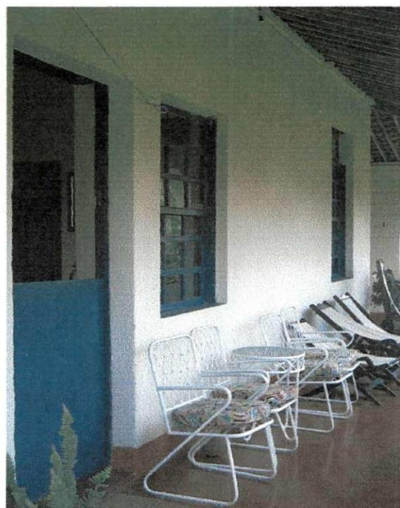
Figura 60 – Portas em madeira maciça, com duas folhas horizontais e janela tipo guilhotina com folhas de segurança, parte fixa com vidro
