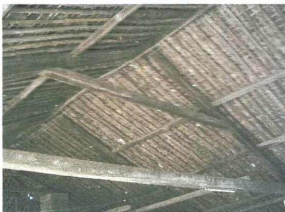
Figura 44 – telhados em 2 águas, com tesoura formada por viga de madeira inteira – Engenho Mineiro
