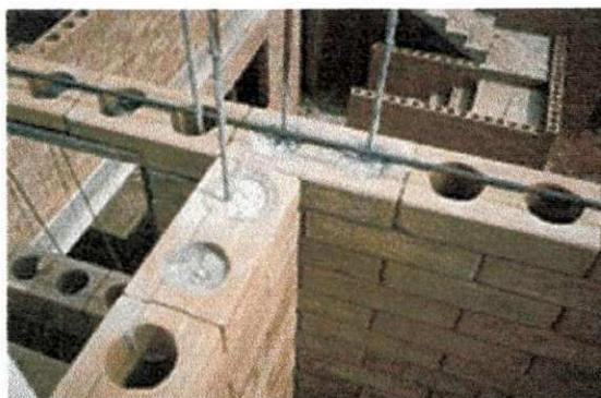
Figura 6 – Tijolos de solo-cimento
