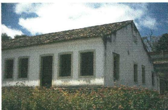
Figura 33 a. Telhado de 02 águas do Engenho da Várzea
