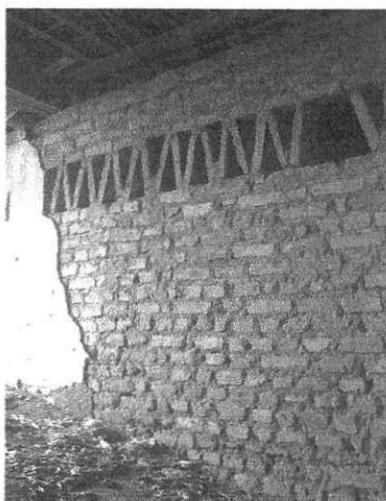
Figura 24- Alvenaria em tijolos manuais
