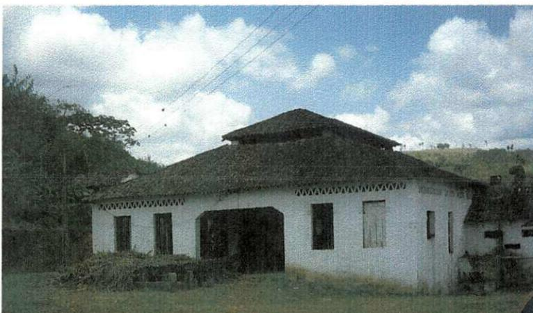
Figura 40 – Telhado em 04 águas, c/ cobertura central elevada – Engenho Vaca Brava de Baixo
