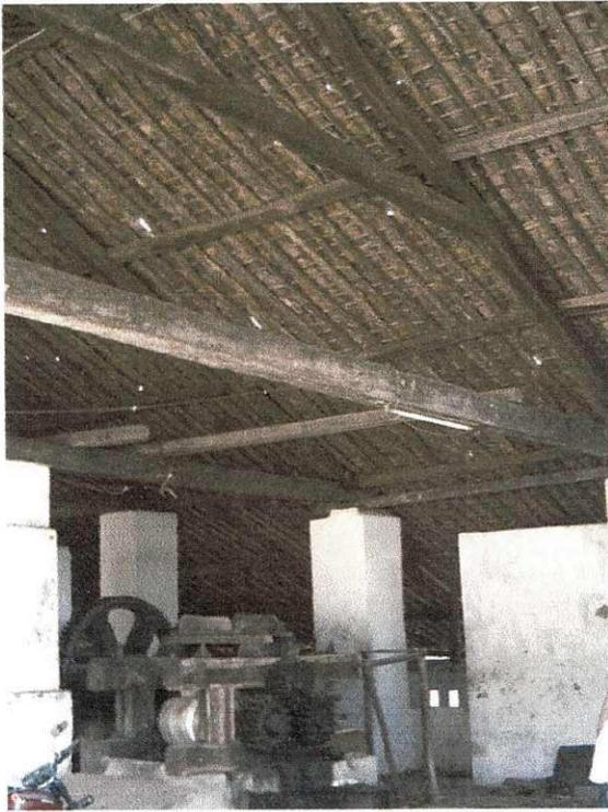
Figura 26 – Colunas autoportantes em alvenaria de tijolos de adobe, rebocada, com tesouras, vigas e esteios de madeira – engenho Mineiro
