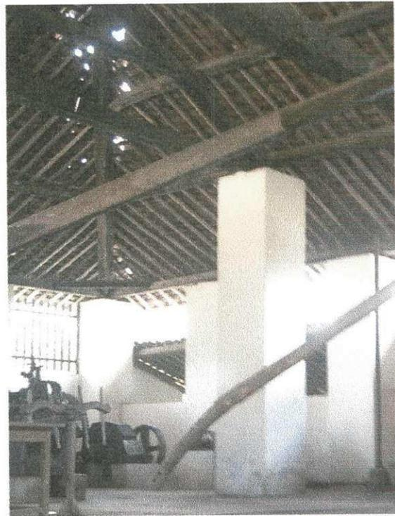
Figura 27 – Colunas autoportantes em alvenaria de tijolos de adobe, rebocada, engenho da Várzea.
