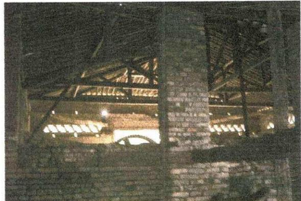
Figura 29 – Colunas autoportantes em alvenaria de tijolos de adobe visto, engenho do Meio (Bujari).
