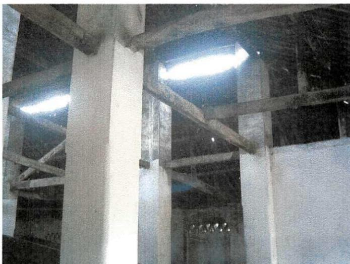
Figura 39 – Colunas autoportantes em alvenaria de tijolos de adobe, com vigas e esteios de madeira – Engenho Vaca Brava de Baixo
