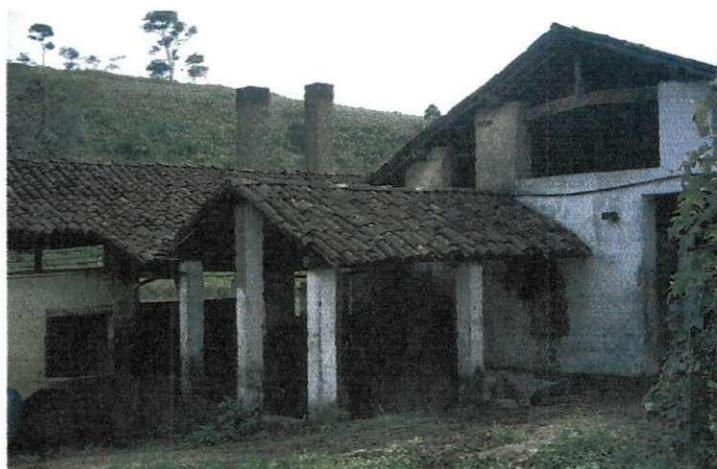
Figura 37 – Telhado em duas águas, colunas autoportantes em alvenaria de tijolos de adobe, com tesouras – Engenho Bujari
