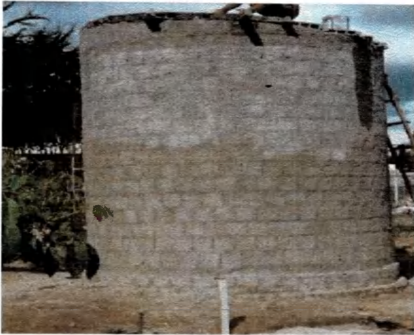
FIGURA 04 - Silo em fase de construção
