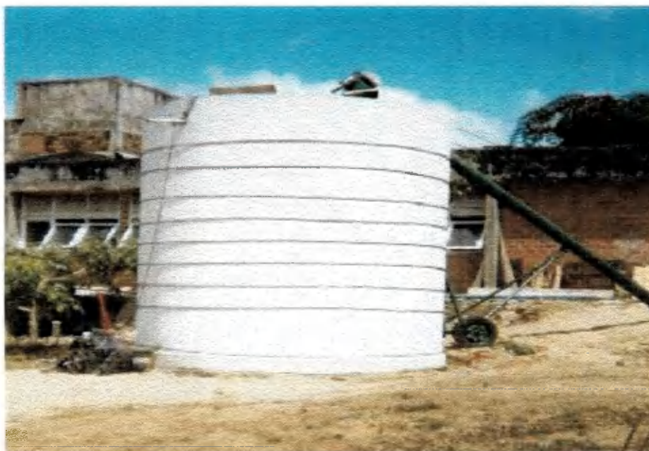
FIGURA 07 - Silo reforçado com barras de aço
