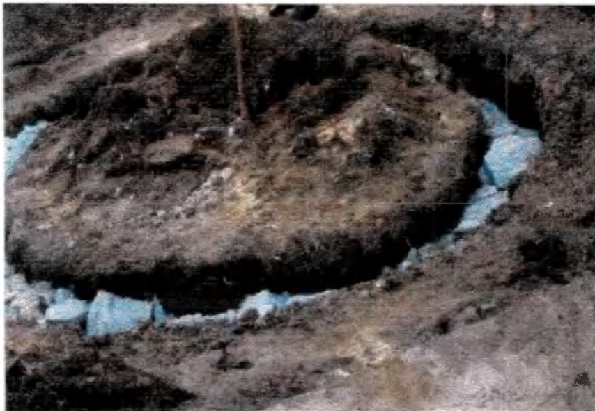
FIGURA 05 - Fundação em pedra
