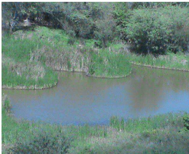
Figura 4: Barragem Principal do Horto Florestal
