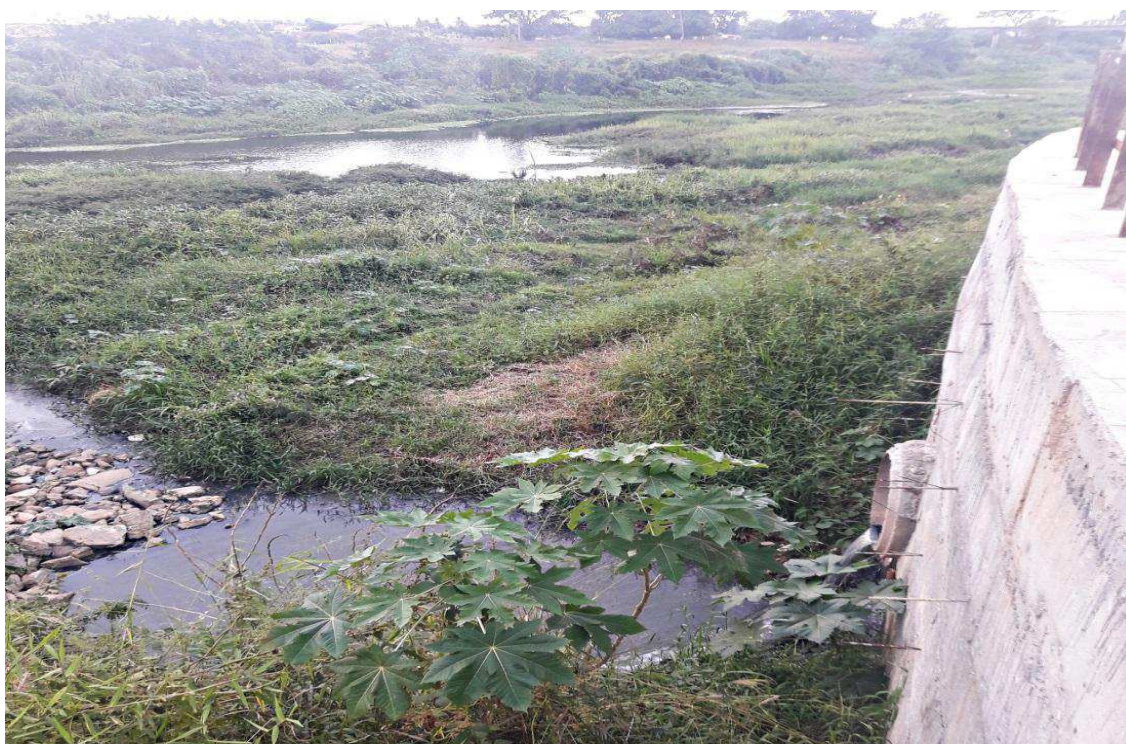
Figura 07. Esgoto da cidade sendo despejado no rio Salgado.
