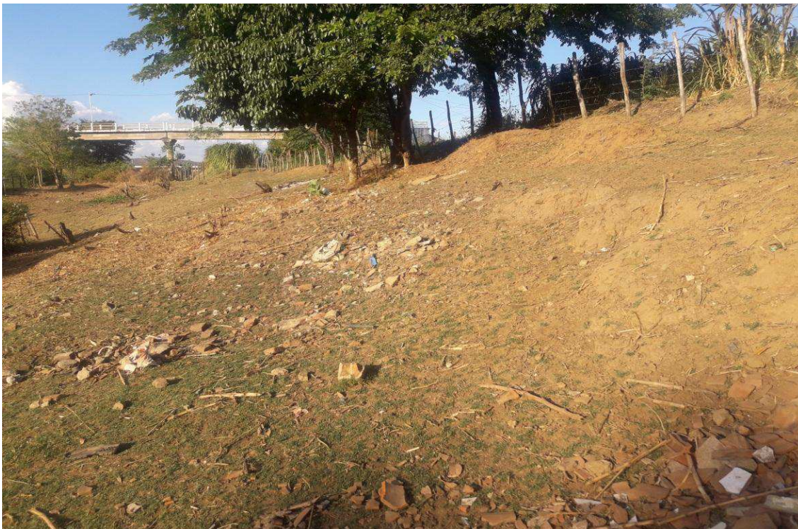
Figura 10. Áreas sujeitas ao processo de erosão.
