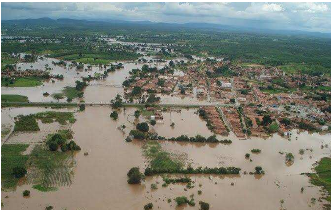
Figura 12. Cheia no rio Salgado na cidade de Lavras da Mangabeira- 2008.
