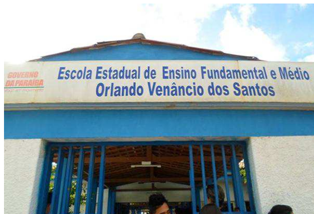
Figura 01: Vista da entrada da escola Orlando Venâncio 2
